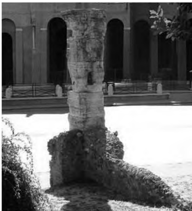
Pilastro in blocchi di travertino con modanatura nella parte superiore con murature e pilastri in opus caementicium addossati al pilastro.
