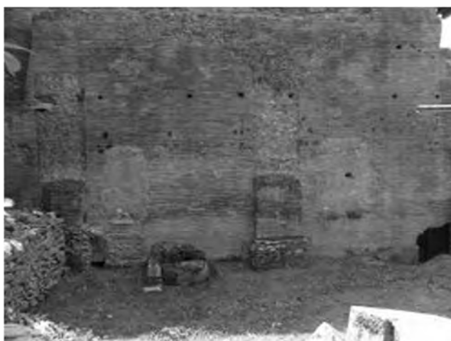
Angolo SE del magazzino, con strutture tamponate dall'intervento massenziano e indicazione, in negativo, del sistema di copertura.
