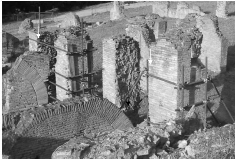
Fig. II. 12 - Pilastri in travertino e in laterizio nelle strutture in alzato: a-c) X 1- Horrea Vespasiani ; la freccia indica il punto in cui si collocavano i pilastri in blocchi; b) Pilastro in blocchi di travertino ancora conservato nel VIII 2-Magazzino del Foro Olitorio, con i rinfianchi in laterizio.
