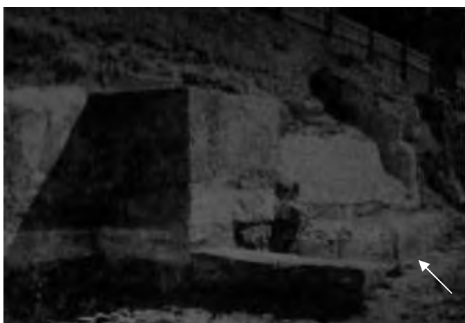
Magazzino IX 6 del Portus Tiberinus . Angolo NW. In primo piano è visibile la soglia in travertino, in secondo piano le fondazioni in opus caementicium con segni di sbatacciatura (Colini-Buzzetti 1986).
