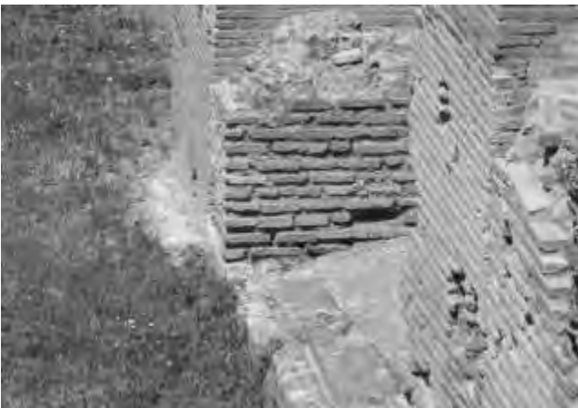
Soglia di travertino in situ nel vano 48.
