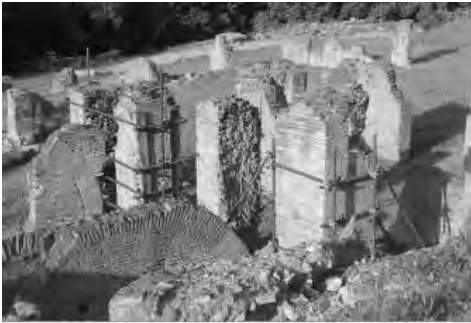
Strutture residue dei vani orientali dell'edificio est, costituite da muri d'alzato in cementizio e cortina laterizia addossati al sistema di tre pilastri combinati.
