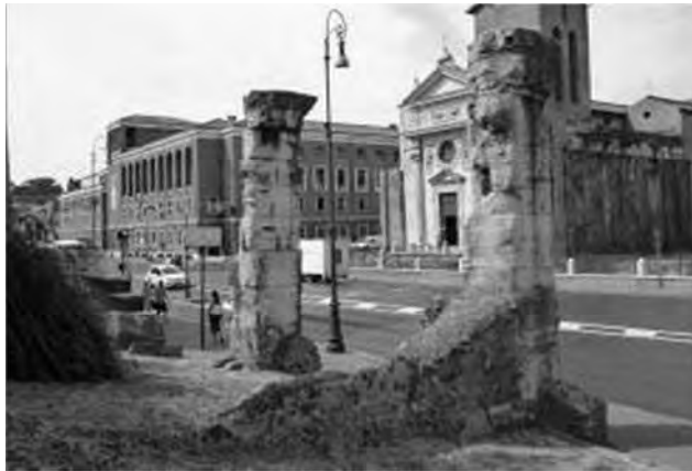
Pilastri in blocchi di travertino con murature e pilastri in opus caementicium addossati ai pilastri.
