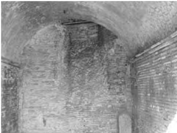
Volta a botte conservata nel vano 23.
