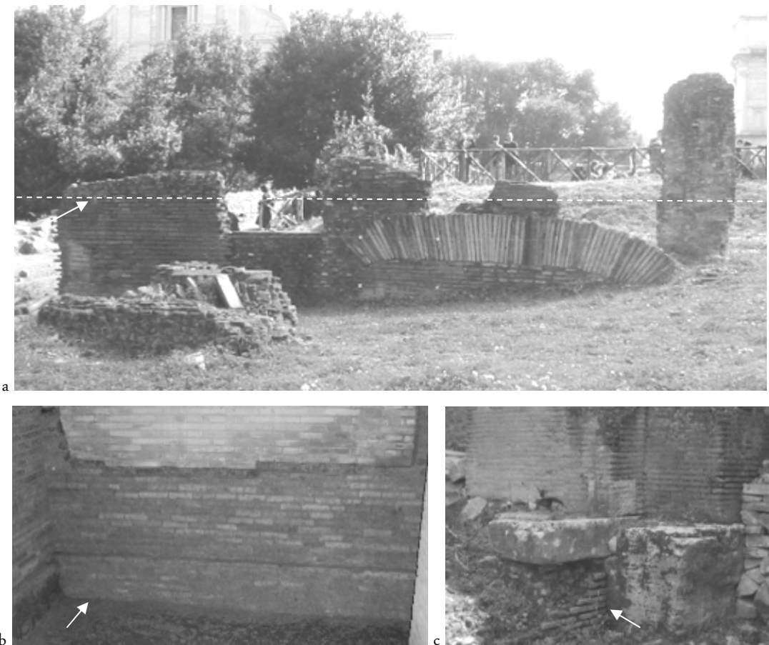
Fig. II. 6 - Fondazioni rivestite con cortina laterizia a) X 1- Horrea Vespasiani : la freccia indica l'assenza di risega, nel punto individuato dall'analisi autoptica, come fine della fondazione e inizio dell'alzato; b) IX 12-Magazzino della via Lata (sotto San Lorenzo Lucina) con fondazione rivestita di laterizi (indicata dalla freccia sotto al marcapiano); c) IV 2- Horrea Piperataria , cortina in fondazione (indicata dalla freccia) sotto la soglia e a fianco del blocco di travertino sopra al quale è stato costruito il pilastro in laterizio.
