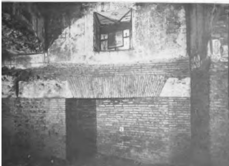
III 1, Magazzino pre-neroniano dell'Oppio. Apertura (a) tamponata nell'adattamento al cantiere neroniano. Sono visibili gli elementi in travertino per la controspinta della piattabanda e la finestra in posizione assiale sopra la porta (Fabbrini 1987).
