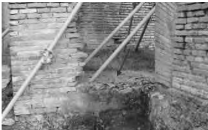
Strutture residue dei pilastri in opera cementizia e spazio occupato dai blocchi di travertino asportati.
