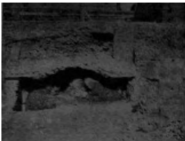
Magazzino IX 2 del Portus Tiberinus . Volta a crociera dell'ambiente 6 crollata. (Colini-Buzzetti 1986).
