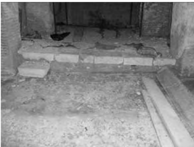
Vano 3, con i pilastri aggiunti in età severiana, visto dal cortile.
