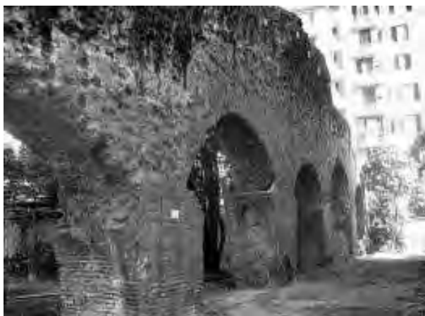
Pilastri ed arcate della navata perpendicolare al muro di fondo.
