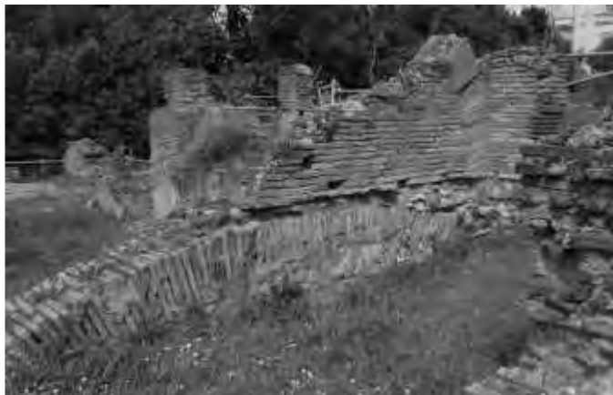
Strutture murarie in cementizio, dotate di arco di scarico sia a livello fondale che in alzato, corrispondente alla parete settentrionale del vano 45.
