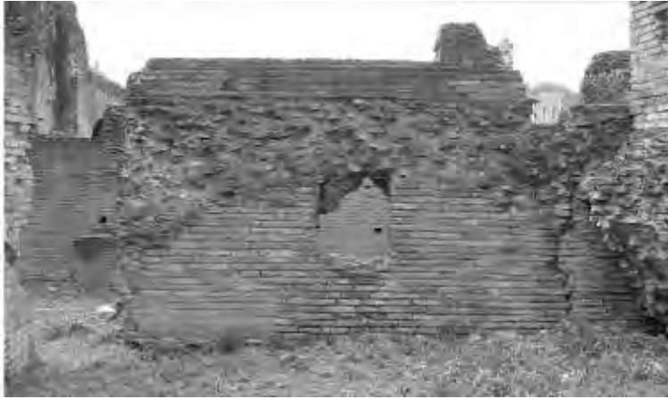
Resti della volta a botte nel vano 60, con finestra aggiunta successivamente nella parete.
