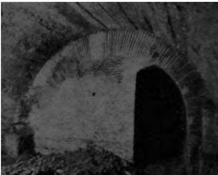
Magazzino IX 1 del Portus Tiberinus . Volta a botte in conglomerato con impronte di assi lignee e pilastri alla base dell'imposta. L'apertura nel muro di fondo, sotto l'arco di scarico, indica che il livello più alto della parete era frequentabile, ad esempio tramite un mezzanino. (Colini-Buzzetti 1986).
