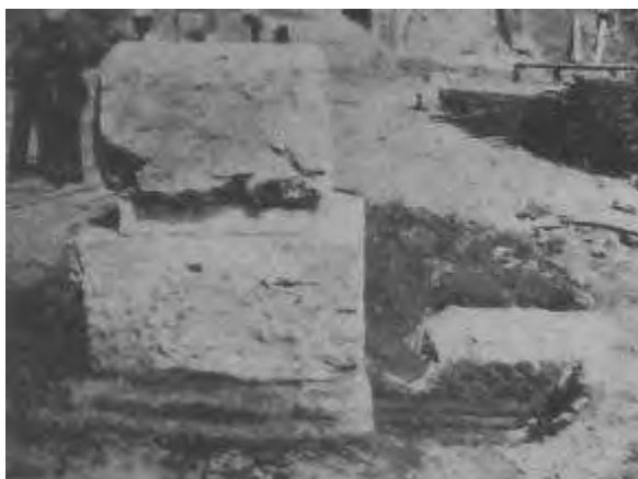
Magazzino IX 5 del Portus Tiberinus . Particolare costruttivo del muro in opus mixtum addossato al pilastro in travertino. (Colini-Buzzetti 1986).
