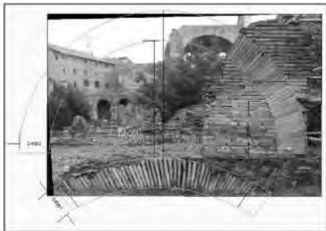
Archi di scarico posti a livello fondale e in alzato, con marcapiano di bipedali (vano 50).
