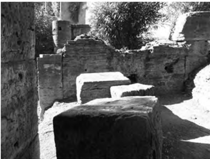
Tamponatura tra i pilastri, con murature in opus vittatum .
