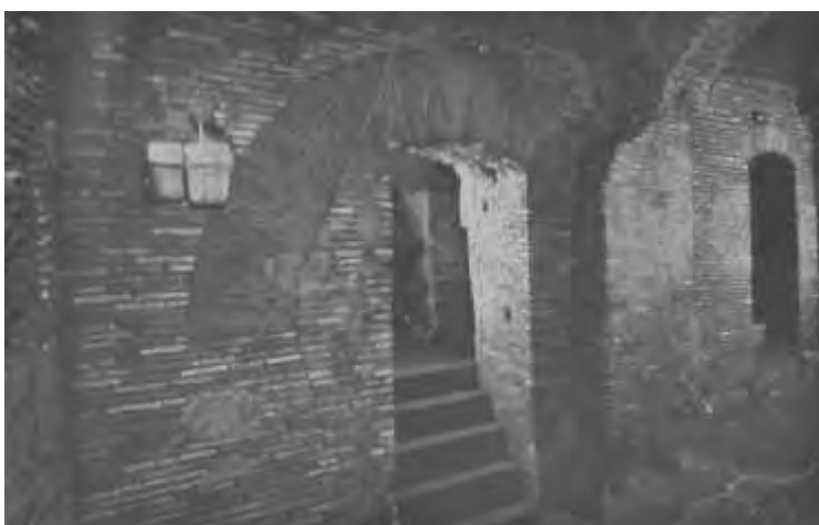
Facciata del magazzino in età severiana. (Quilici 1986-1987).
