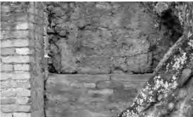
Resti della maglia intradossale in bessali e sesquipedali (non più in situ ) nelle coperture a volta.
