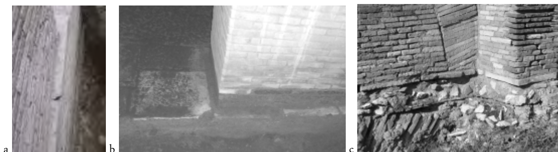
Fig. II. 3 - Esempi di marcapiano inserito sopra lo spiccatto delle fondazioni: a) Sesquipedali nel X 2-Magazzino della via Valle-Foro; b) Sesquipedali nel IX 12-Magazzino in via Lata (sotto la chiesa di S. Lorenzo in Lucina); c) Bipedali nei X 1- Horrea Vespasiani .
