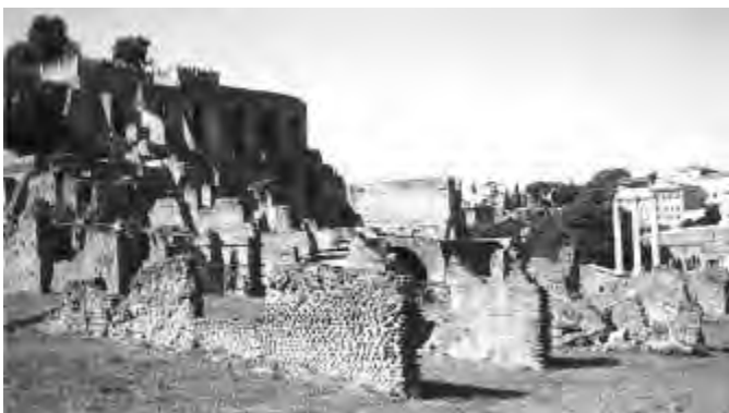
Strutture fondali con cortina laterizia corrispondenti ai vani (4, 5, 6, 7).
