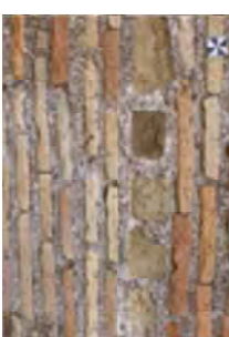
d) Cortina laterizia dei pilastri del portico redifricati in età diocleziana (Bauer 1978).
