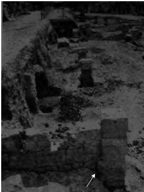
Magazzino IX 2 del Portus Tiberinus . Ammorsatura tra il muro in opera quadrata di tufo litoide (corrispondente alla parete N della cella 8 e pilastri di facciata in blocchi di travertino. (Colini-Buzzetti 1986).
