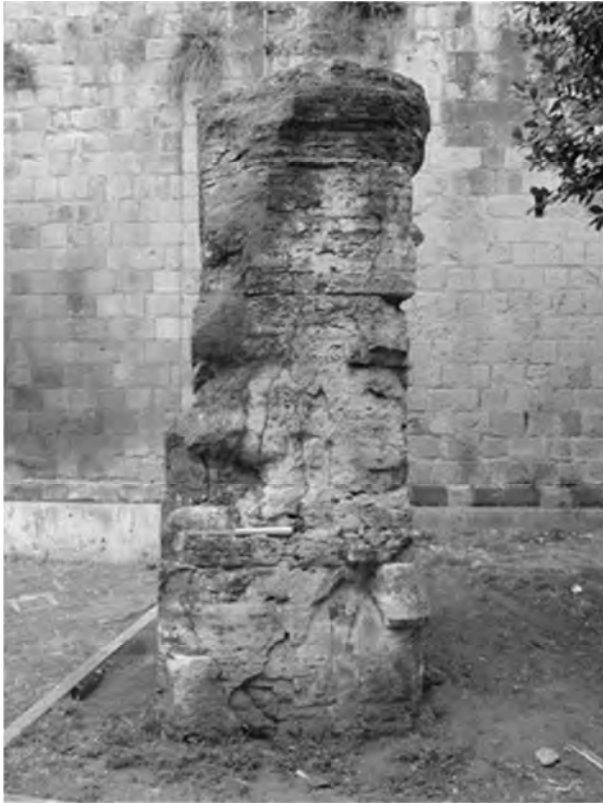
Pilastro in blocchi di travertino posto nella parte NW del magazzino, tra i vani 2 e 3.
