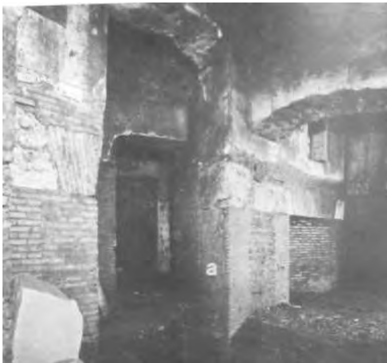
III 1, Magazzino pre-neroniano dell'Oppio. Apertura (a) dell' horreum tamponata e successivamente riaperta nell'adattamento al cantiere neroniano. E' visibile la piattabanda tagliata e la sottostante tamponatura. In basso a sinistra l'apertura precedente. (Fabbrini 1987).
