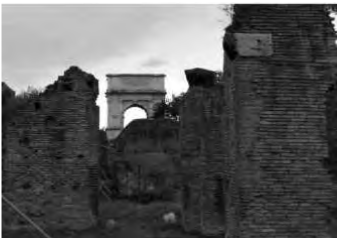
Vani perimetrali del cortile orientale, con murature dotate di mensola in travertino per il sostegno di un ballatoio ligneo esterno.
