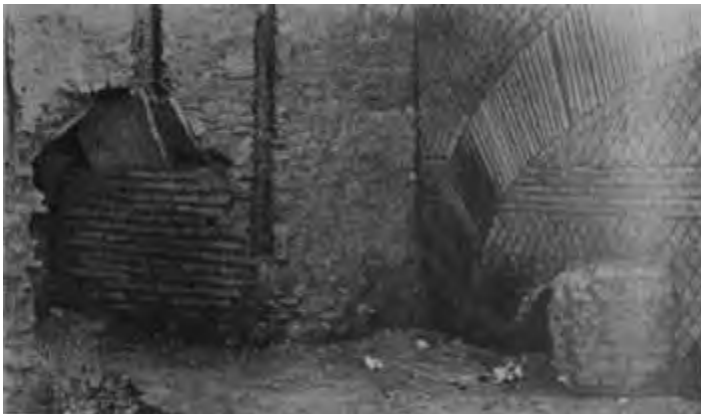
XIII 20, Emporium -Edificio argine. Tramezzo con cortina in opera mista e parete di fondo corrispondente a una fondazione nella quale era collocata una cloaca. (Cressedi 1956).
