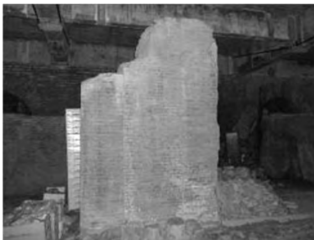
Pilastri del portico in cementizio e cortina laterizia, composti da un pilastro centrale, appartenente alla fase originale dell'impianto, e due pilastri di rinfianco aggiunti successivamente.
