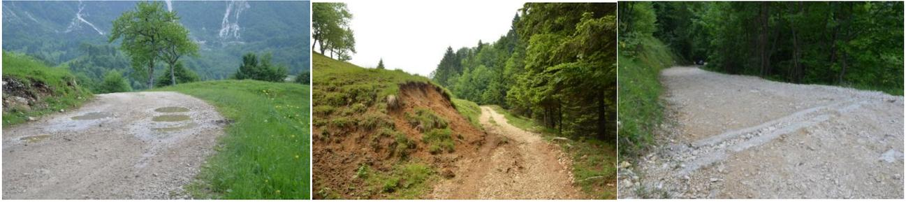
Figura 15: esempi di scarsa manutenzione (Tracciato 1)
