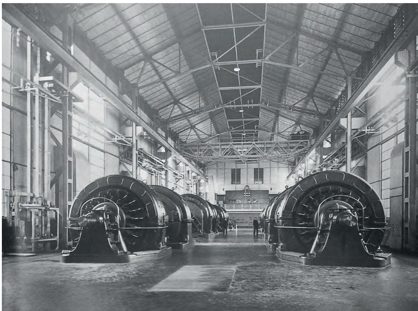
1.53 Reale Fotografia Giacomelli, Porto Marghera, sala turbine alla Sava , 1936
