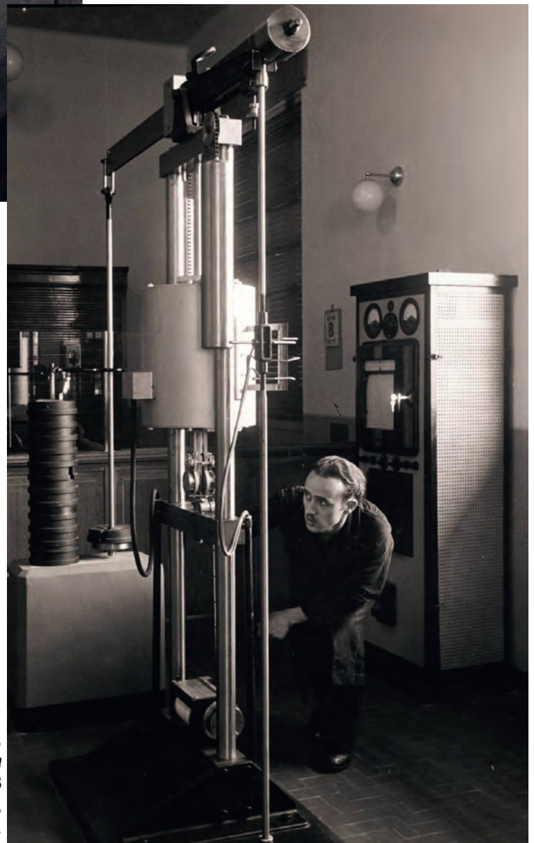
1.16 Bruno Stefani per Studio Boggeri, Dalmine, laboratorio centrale, prove di scorrimento a caldo, 1938 AFFD, DA_F_p00082_007, © Dalmine s.p.a. Archivio Fondazione Dalmine.
