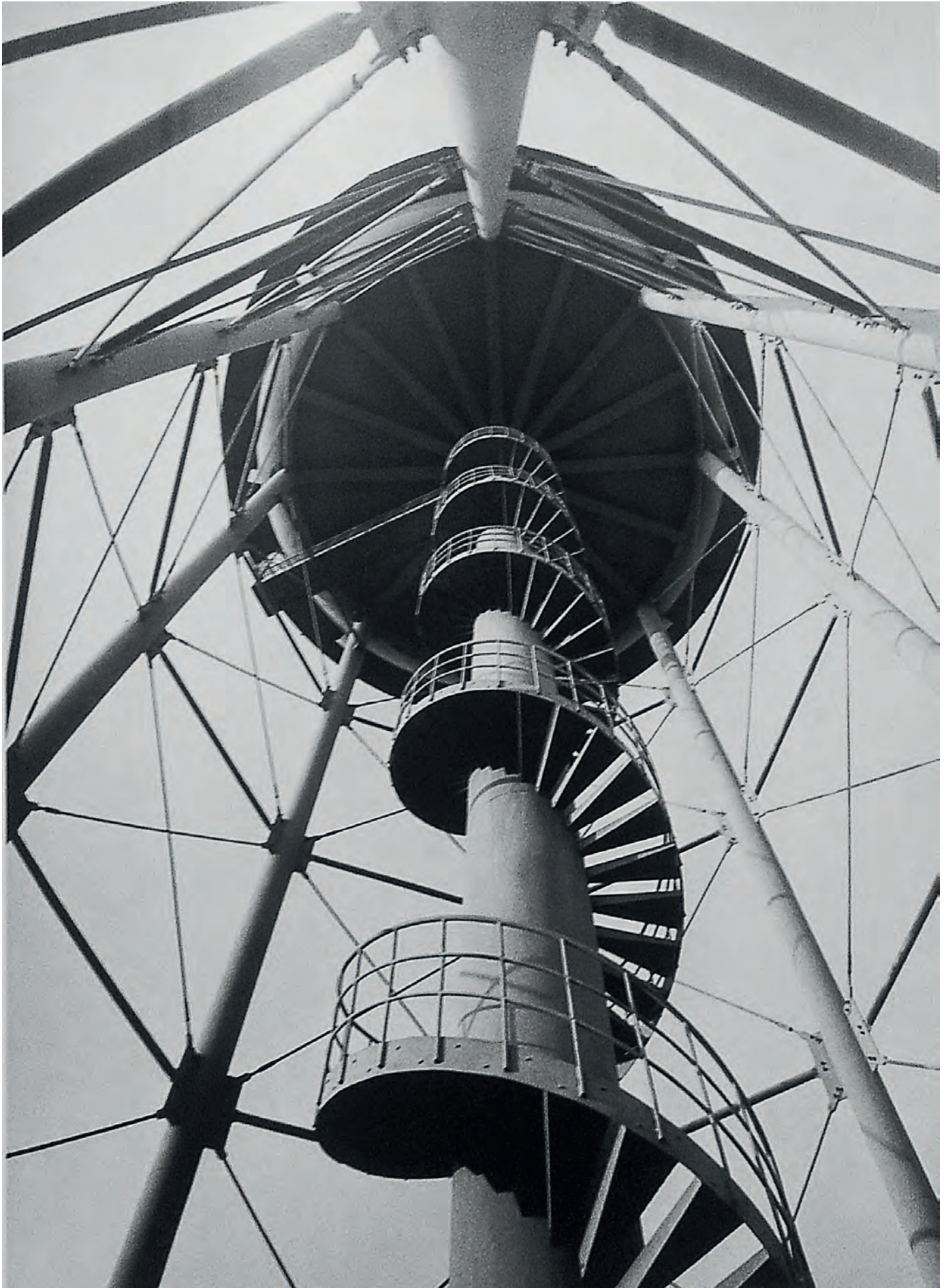
3.24 Studio Da Re, Serbatoio per acqua, Acciaierie Dalmine , fine anni '50.
