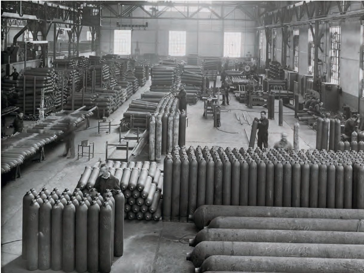
2.18 Foto Rossi, Dalmine , reparto bombole, anni quaranta. AFFD, DA_F_p00071_019, © Dalmine s.p.a. Archivio Fondazione Dalmine.
