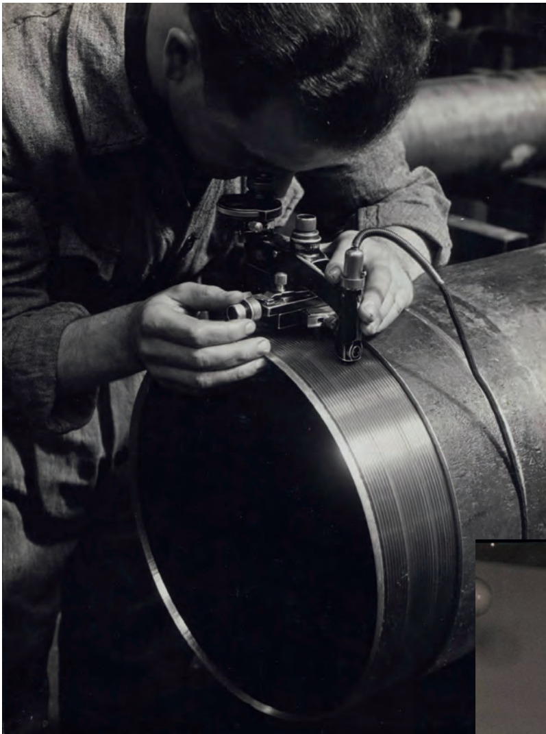
1.15 Bruno Stefani per Studio Boggeri, Dalmine, reparto trivellazione, verifica del profilo della filettatura con microscopio portatile, 1938 AFFD, DA_F_p00065_008, © Dalmine s.p.a. Archivio Fondazione Dalmine.
