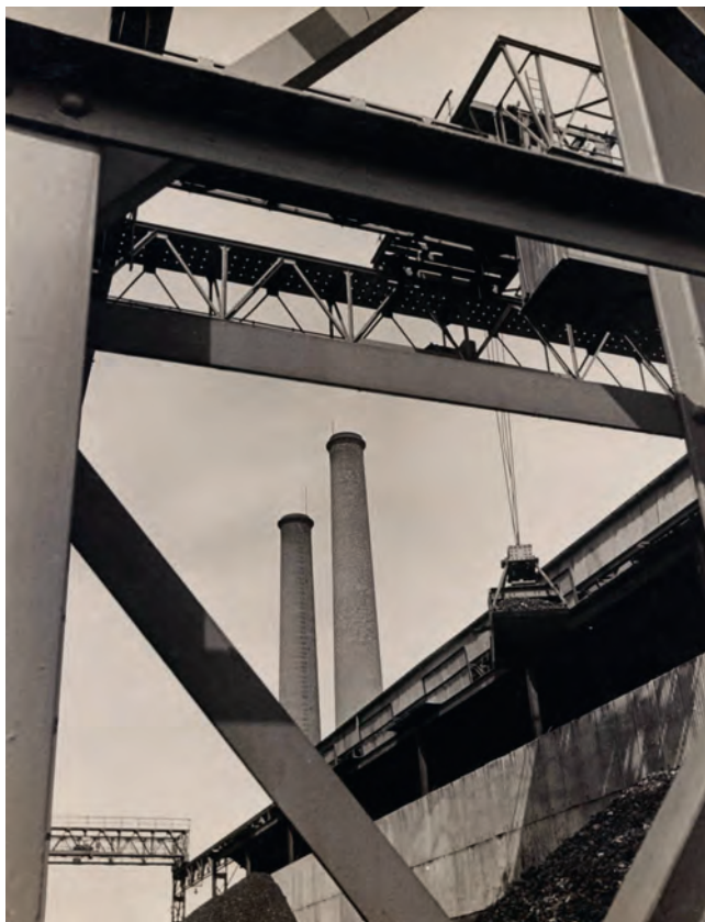
1.4 Bruno Stefani per Studio Boggeri, Dalmine, acciaieria Martin Siemens, esterno , 1937. AFFD, DA_F_p00009_040 © Dalmine s.p.a. Archivio Fondazione Dalmine.
