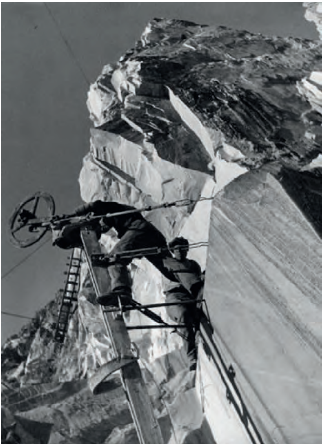
1.22 Bruno Stefani, Due operai sistemano il filo elicoidale per il taglio dei blocchi di marmo , Carrara, 1935, Fondo Edison EDS_ST_DV_153
