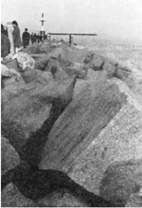
Fig. 23 – Porto Garibaldi di Comacchio (FE), coronamento del molo sud in blocchi di trachite di Monte Merlo (CALVINO 1969, p. 26, fig. 4).
