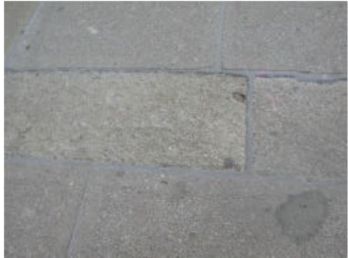
Fig. 27 – Venezia, lastre trachitiche soggette ad attacco salino (VALLUZZI et alii 2005, p. 3, fig. 2).
