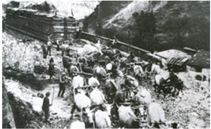
Fig. 1 – L'obelisco del Foro Italico trasportato dalle cave di Carrara su slitte trainate da buoi (ADAM 2008 9 , fig. 32, p. 30).
