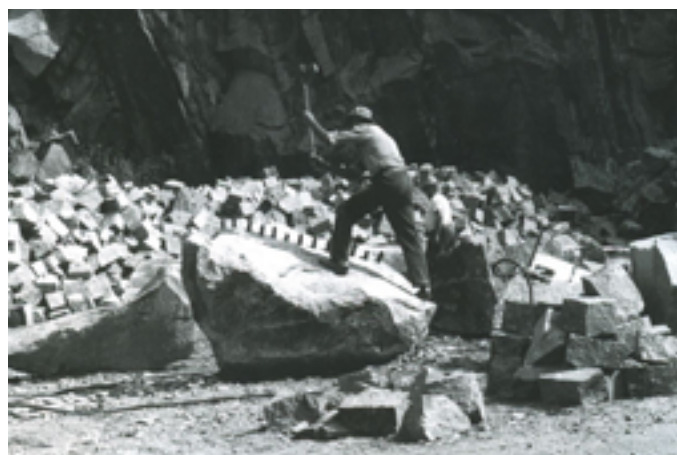
Fig. 31 – Zovon di Vo' Euganeo (PD), 1975. Tagliata a mano di un masso di trachite con mazza e cunei (VERGANI 2005, p. 281).
