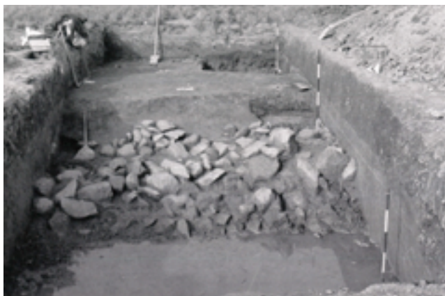
Fig. 16 – Montagnana, località Borgo San Zeno. Scogliera in blocchi trachitici di difesa spondale del paleoalveo dell'Adige, fine I sec. a.C. - I sec. d.C. (MI 327) (BALISTA, BIANCHIN CITTON 1987, fig. 6, p. 14).
