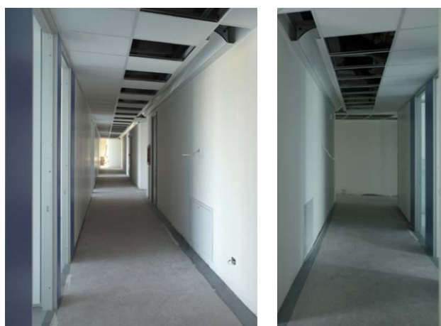
Figura 60. Corridoio: fotografie di cantiere.
