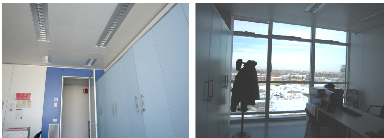
Figura 59. Dettagli soffitto microforato (a sinistra) e vetrata esterna (a destra) negli uffici.
