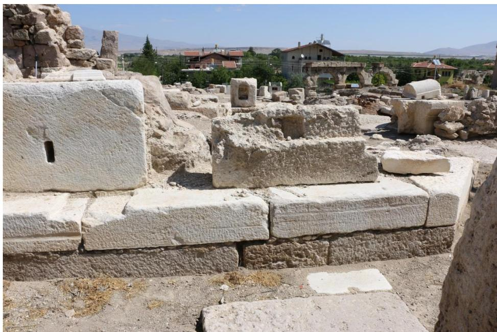
*Fig. 2: particolare della muratura presso l'abside dove si riconosce l'impiego del poros nelle fondazioni e il marmo nello spiccato.*
