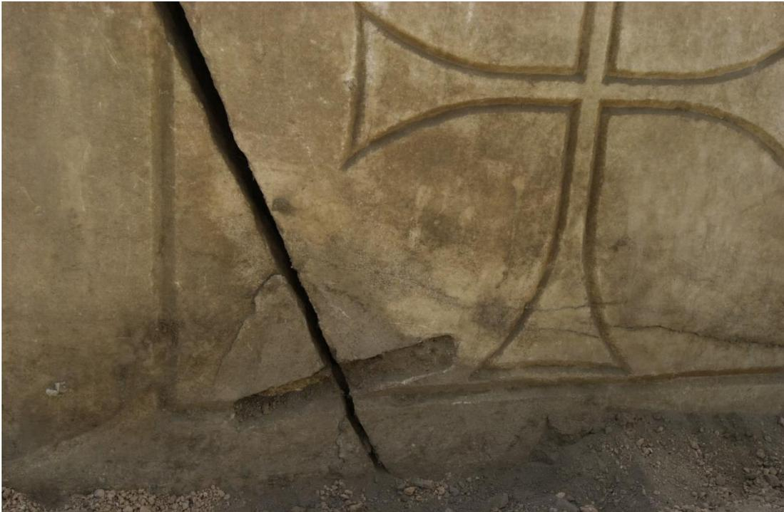
*Fig. 23: Particolare della parete esterna della vasca battesimale con l'incavo di una grappa metallica trasversalmente ad una frattura.*
