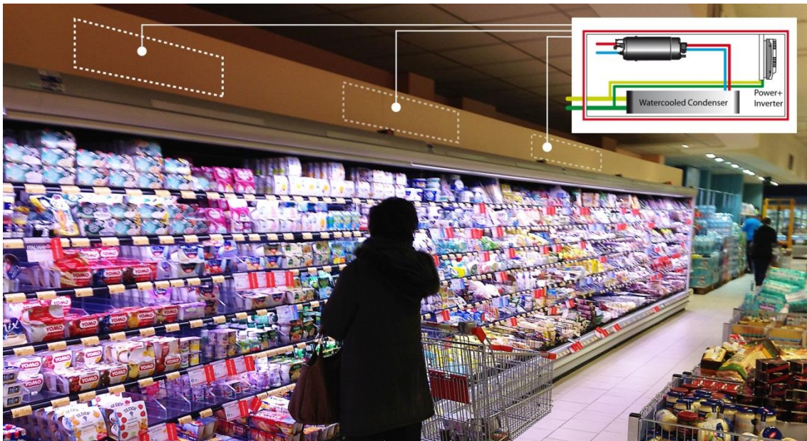
Fig. 4.5 – Foto di alcuni espositori frigoriferi tipo “multi-deck open” con compressore e condensatore a bordo (Carel Industries, 2014).
