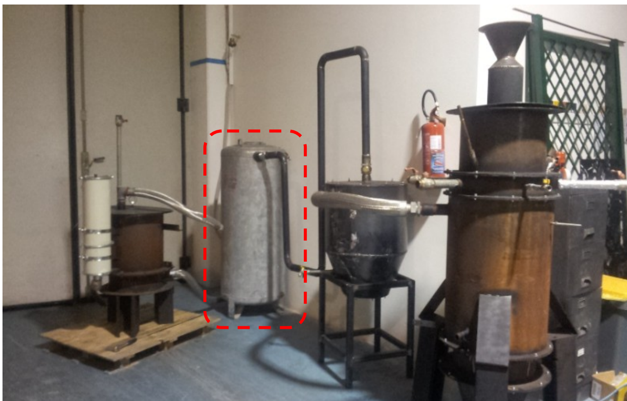
Figura 4-33 Collegamento del sistema di accumulo
