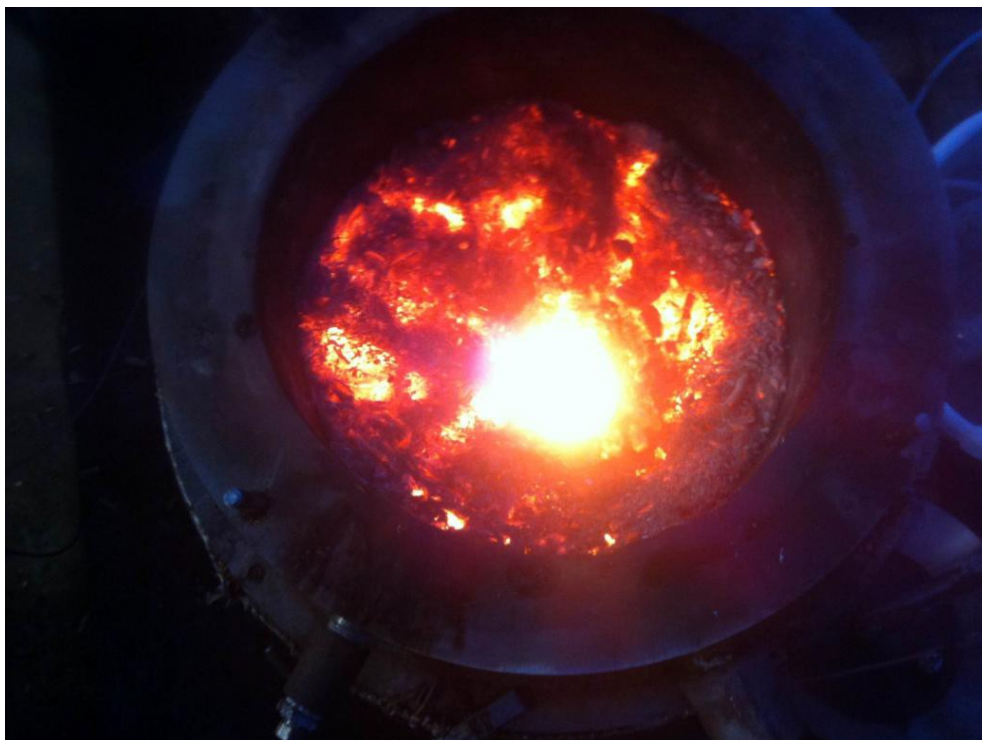
Figura 4-21 Fenomeno di bridging nel reattore (zona di tiraggio solo centrale)
