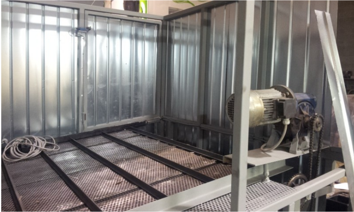
Figura 4-16 Sistema di pre-trattamento ed essiccamento della biomassa residuale
