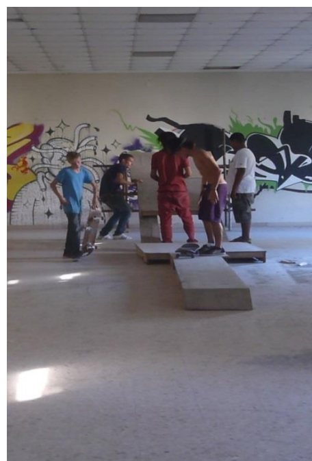
17. Costruzione pista da skate-padiglione ex cucine
