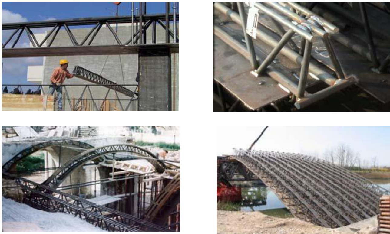
Figura 1.4: Recenti strutture realizzate con travi reticolari miste
