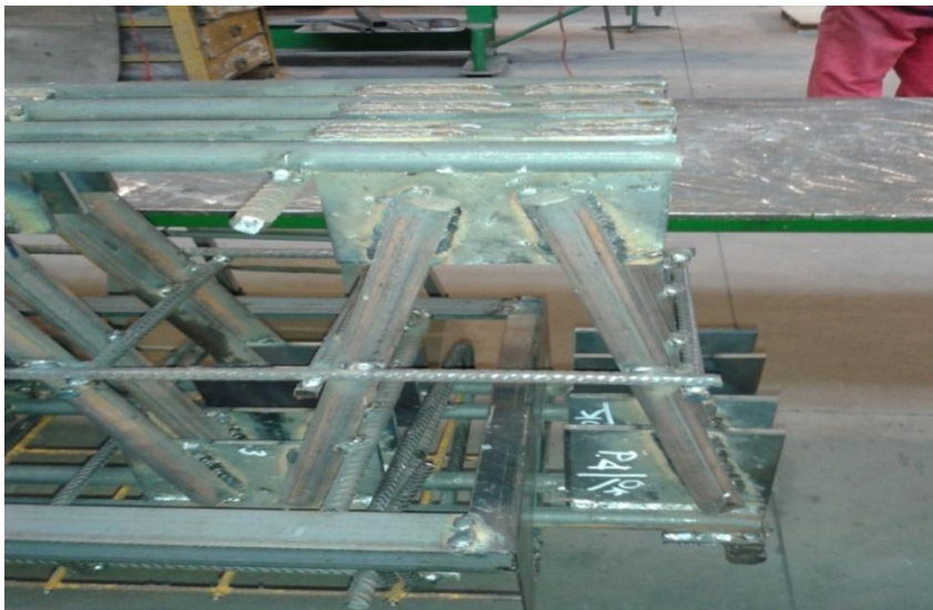
Figura 2.21 e 2.22: Particolari nodo trave TRR Ponte 104
