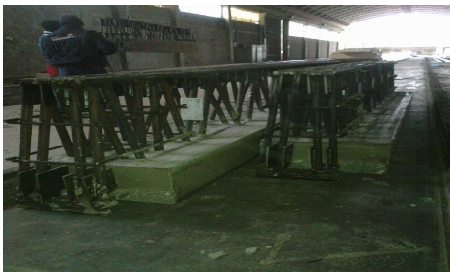
Figura 2.26: fase di getto dello zoccolo
