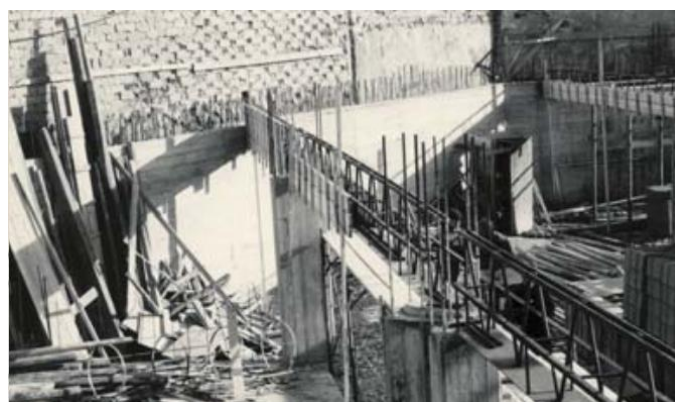
Figura 1.3: Prime strutture realizzate con travi reticolari miste
