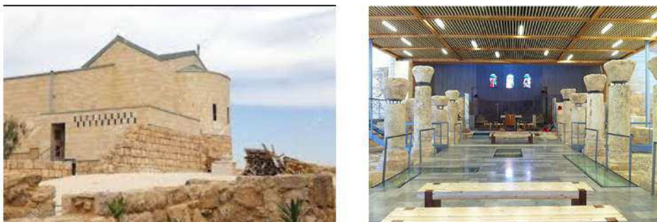
Figura 4.23: Memoria di Mosé, vista esterna e interna parzialmente riadattato a chiesa (da [26]; [27] )
