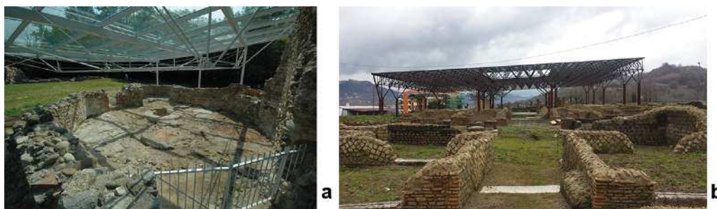
Figura 2.7: Condizioni di pericolo non mitigate dalla copertura: a) effetto serra indotto dalla copertura vetrata (area archeologica a Cividate Camuno, BG); b) assenza di protezione laterale (area archeologica di Atripalda, AV)
