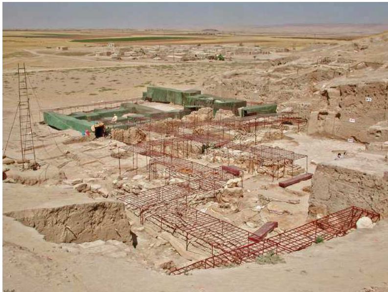
Figura 4.22: Tell Mozan (Urkish) la copertura di protezione delle murature parzialmente scoperta a rivelarne la struttura metallica interna (da [25])
