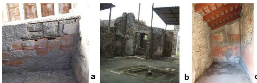
Figura 9.9: Esempi di ricostruzioni di solai recenti a soli fini didattici e non strutturali a Pompei
