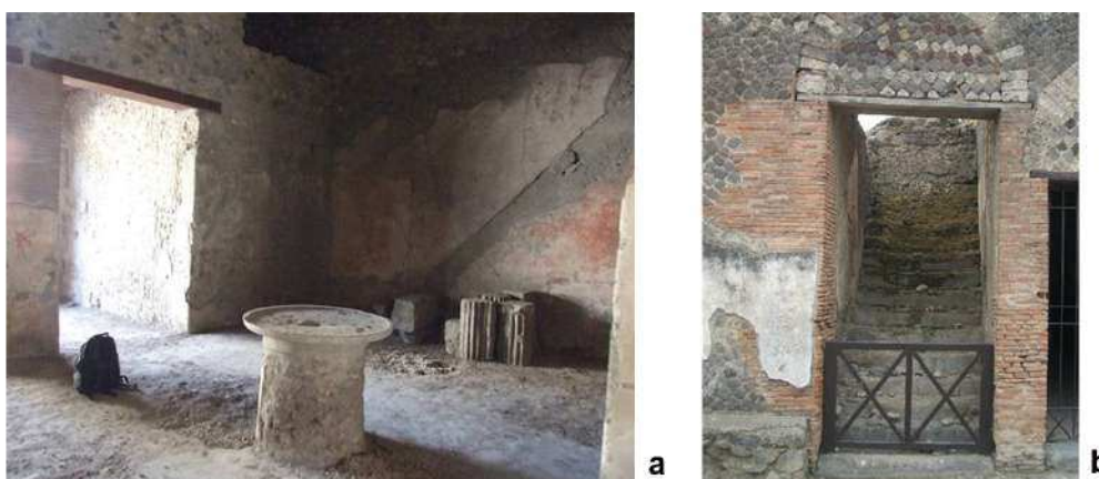
Figura 7.20: Esempi di scale a Pompei: a) traccia della scala in legno nell'intonaco della parete dell'atrio della casa I,12,15; b) scala di accesso ai livelli superiori delle terme del foro (da [17])
