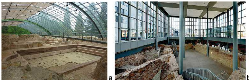
Figura 4.26: Copertura archeologica di (a) le terme romane di Badenweiler (da [31]); b) le terme romane di Treviri (da [32])
