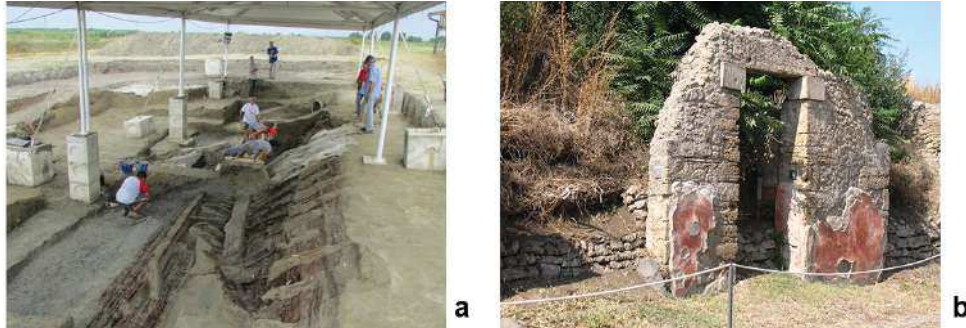
Figura 2.12: Condizioni di pericolo determinate dalla configurazione dello scavo: tagli verticali su terreno argilloso (scavo a Comacchio, FE); fronti scoscesi in terreni incoerenti (Pompei, regio IV)
