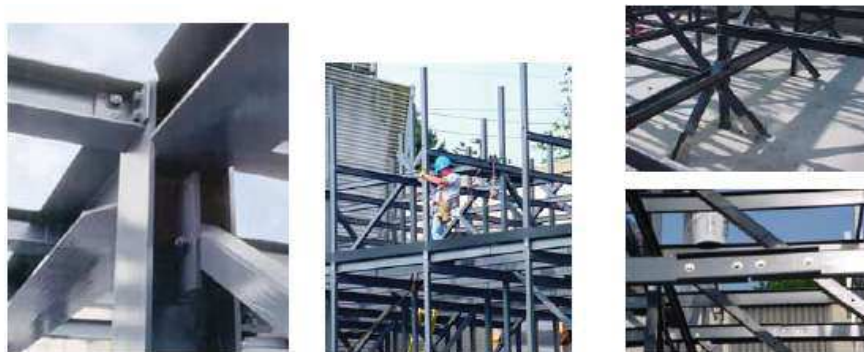
Figura 6.48: Giunti di telai strutturali tipo stick-built suggeriti dalla ditta americana Strongwell (da Mottram 2009)
