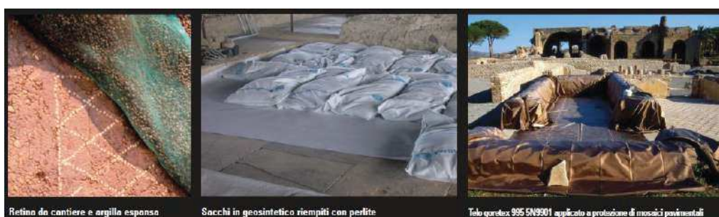
Figura 4.40: Predisposizione del rinterro secondo Laurenti 2006
