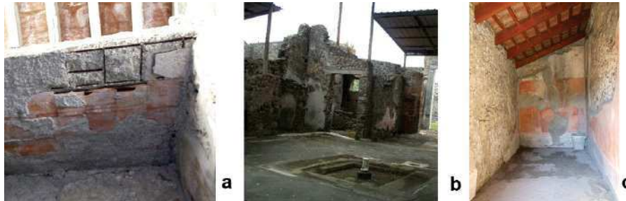
Figura 9.6: Esempi di coperture impiegate a Pompei: a) solaio SAP in breccia sulle murature archeologiche in condizioni di forte degrado (VI,11,9); b) coperture leggere su sostegni metallici indipendenti dalle murature (VII,1,40); c) copertura in legno di recente costruzione con manto sottotegola in fascine di legno e in appoggio sulla muratura (VI,9,2) (da [17])
