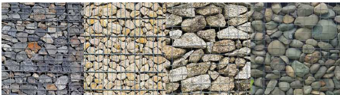
Figura 6.10: Esempi di texture ottenibili variando il tipo e la forma degli inerti utilizzati nel gabbione
