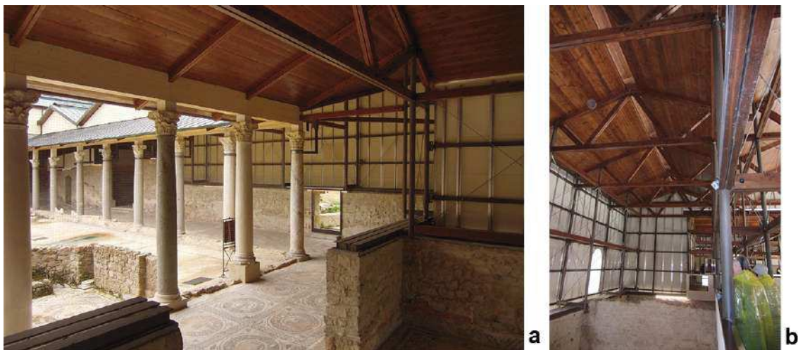
Figura 6.31: Nuova musealizzazione della villa del Casale: a) vista del peristilio con la trave di bordo del tetto e il cordolo di base in primo piano; b) vista della copertura reticolare
