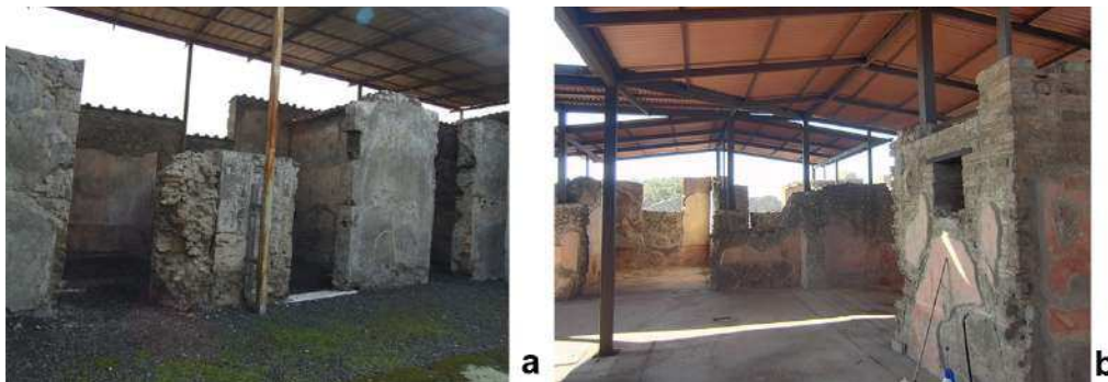
Figura 4.10: Coperture archeologiche di tipo leggero a Pompei: a) struttura provvisoria in metallo con manto in onduline sulla casa VI,9,7; b) struttura definitiva in metallo con manto in fibrocemento sulla palestra al VIII,2,22 (da [17])
