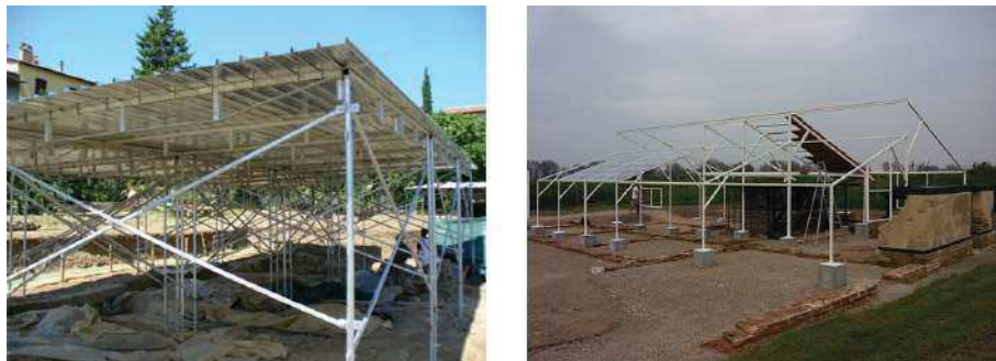
Figura 5.12: Le strutture leggere prefabbricate sono caratterizzate da un impatto sul sito molto limitato in termini di fondazioni e cantierizzazione tuttavia comportano oneri manutentivi notevoli perché si mantengono davvero funzionali e spesso determinano un impatto visivo elevato
