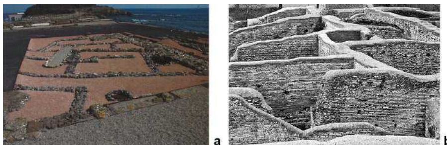
Figura 4.37: Sistemazione di lacerti archeologici conservati in situ all'esterno: a) campiture di ghiaia colorata per evidenziare fasi e ambienti con consolidamento delle creste murarie a raso (da Bonetto et al. 2009); b) copertine di protezione in malta su murature archeologiche in elevato a Ostia (da Pedeli e Pulga 2002)
