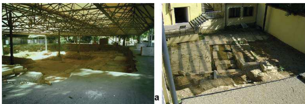
Figura 2.6: Condizioni di pericolo create dalla luce solare nell'interazione con la copertura: a) zone d'ombra alternate a zone di sole diretto (area archeologica a Pesaro); b) illuminazione diffusa con la trama della struttura della copertura (area archeologica di Sarsina, FC)
