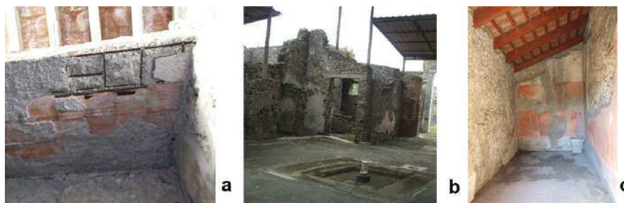
Figura 9.11: Esempi di coperture impiegate a Pompei: a) rovine in forte degrado (VI,2,10); b) ruderi con le creste murarie pareggiate (VI,2,22); c) edifici con copertura di ricostruzione (IX,13,1; da pompeiiinpictures.org)
