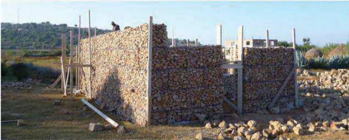
Figura 6.11: La casa in gabbioni durante la costruzione (da Samayoa et al. 2018)
