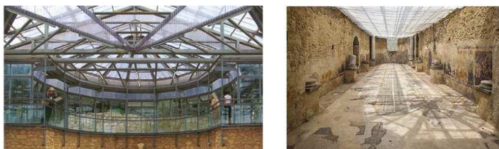
Figura 4.13: Musealizzazione della villa del Casale nella versione progettata da Minissi poco prima del suo smantellamento. È evidente il deterioramento materico e funzionale della struttura
