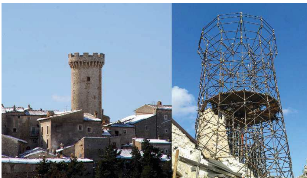
Figura 4.18: La torre di S. Stefano di Sessanio prima del crollo e dopo la sua rievocazione con i tubi innocenti (da [24])
