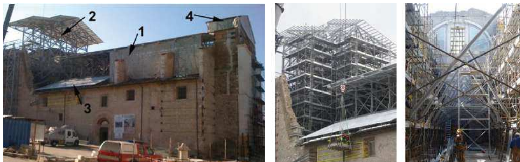
Figura 6.47: Viste esterne e interne dell'intervento di copertura provvisoria con una struttura in FRP della chiesa di S. Maria Paganica a L'Aquila (da Russo et al. 2012)
