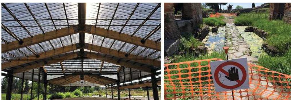
Figura 5.4: La copertura o l'assetto geotecnico ed idraulico del sito possono determinare condizioni di stress per i materiali archeologici e per i visitatori
