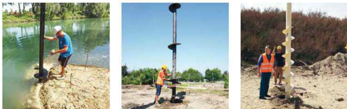
Figura 6.8: Posa in opera di (da sinistra a destra) pali a vite singola; a vite multipla e a vite continua (da Geopal 2016)
