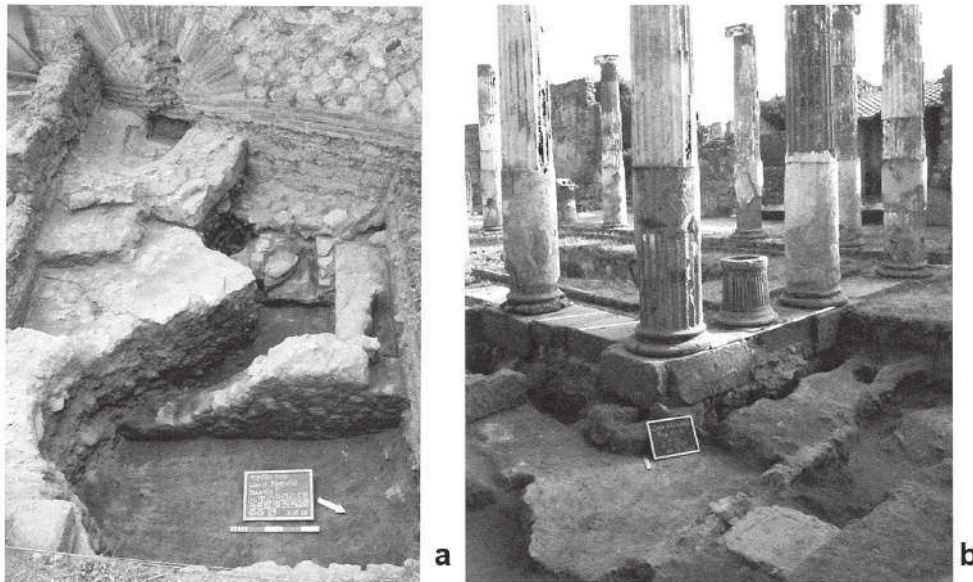
Figura 9.5: Esempi di fondazioni a Pompei: a) in blocchi di peristilio nella casa di Arianna; b) in conglomerato in cavo libero nella casa VII,2,30 (da Pedroni 2011)
