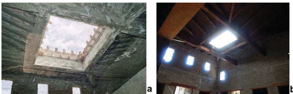
Figura 4.11: Coperture archeologiche di tipo pesante. La ricostruzione dell'atrio della casa VI,15,1 in cemento armato (a) e nella recente sostituzione in legno lamellare (b; da [17])
