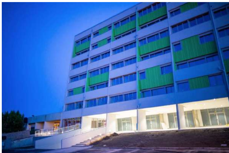
Fig. 10 – Vista del blocco 3 riqualificato. Fonte: Comune di Calderara di Reno.
