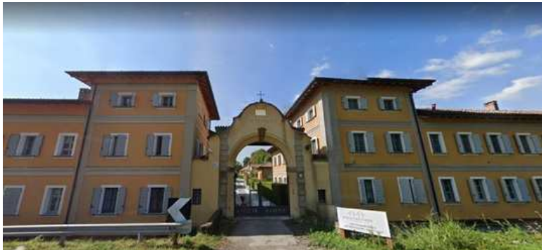
Fig. 2 – Ingresso della GC Borgo di Vione nell'hinterland milanese. Fonte: googlemaps.
