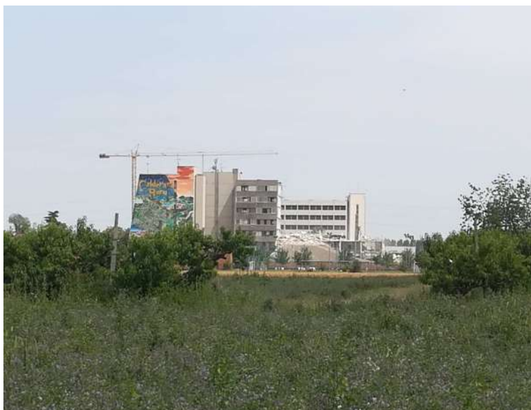
Fig. 15 – Vista della demolizione dei blocchi 4-5-6. Fonte: Comune di Calderara di Reno.
