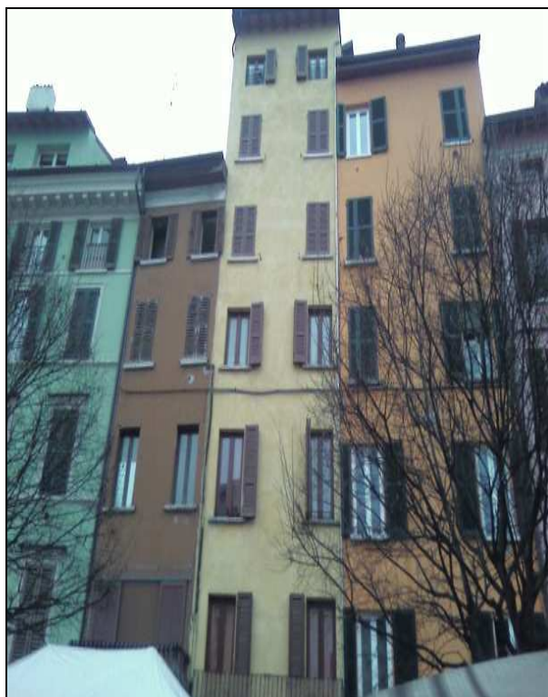
Fig. 15 – Abitazioni, via San Faustino.
