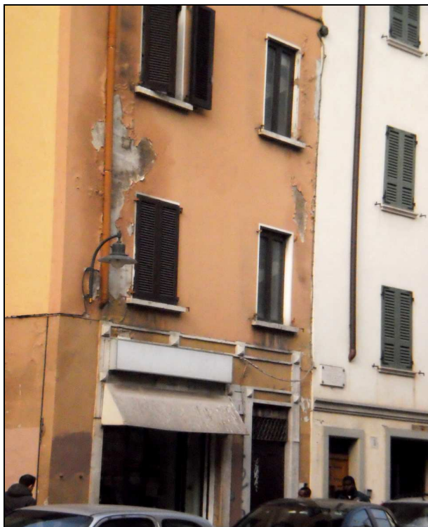
Fig. 20 – Abitazioni, via San Faustino.
