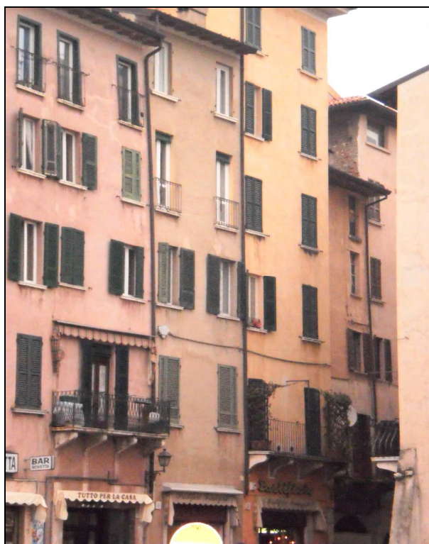
Fig. 16 – Abitazioni, via Maraffio o Rua Sovera.
