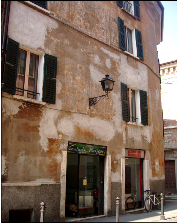
Fig. 17 – Abitazioni e negozio gestito da stranieri (alimentari e macelleria), Contrada del Carmine.
