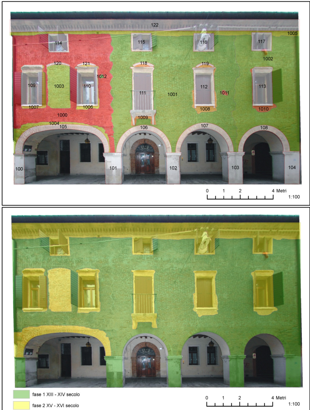
Figura 55: analisi stratigrafica e pianta di fase dell'edificio 1769.
