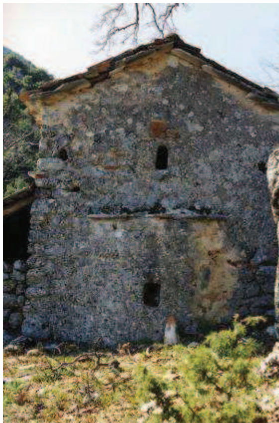
Fig. 48. Ano Parakalamos (Epiro,Grecia), Chiesa di Sant'Atanasio, facciata est.
