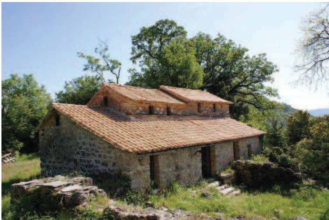
Fig. 45. Ano Parakalamos (Epiro,Grecia), Chiesa di Sant'Atanasio, dopo i lavori di restauro, veduta da sud-ovest.
