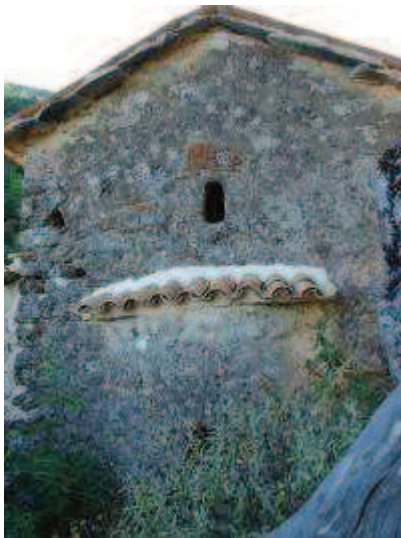
Fig. 51. Ano Parakalamos (Epiro,Grecia), Chiesa di Sant'Atanasio, facciata est.
