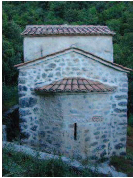
Fig. 11. Repetista (Epiro, Grecia), Chiesa della Metamorfosis, facciata est, dopo il restauro.
