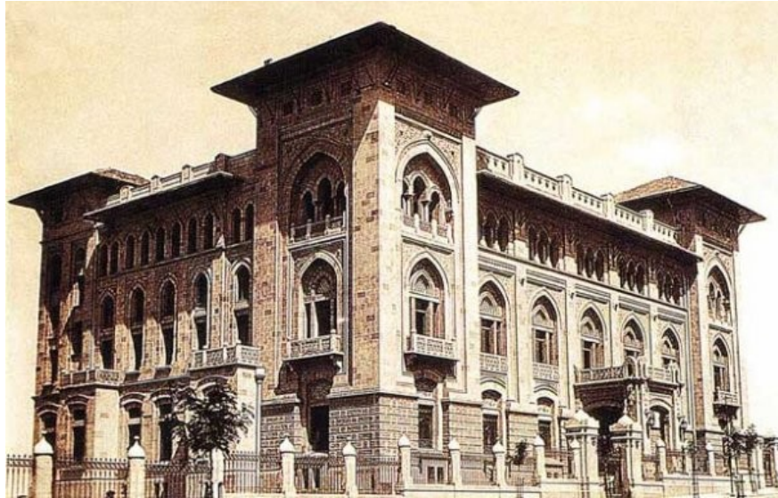
Fig. 35: Giulio Mongeri, Palazzo della Direzione Generale della Banca d'Agricoltura, Ankara
