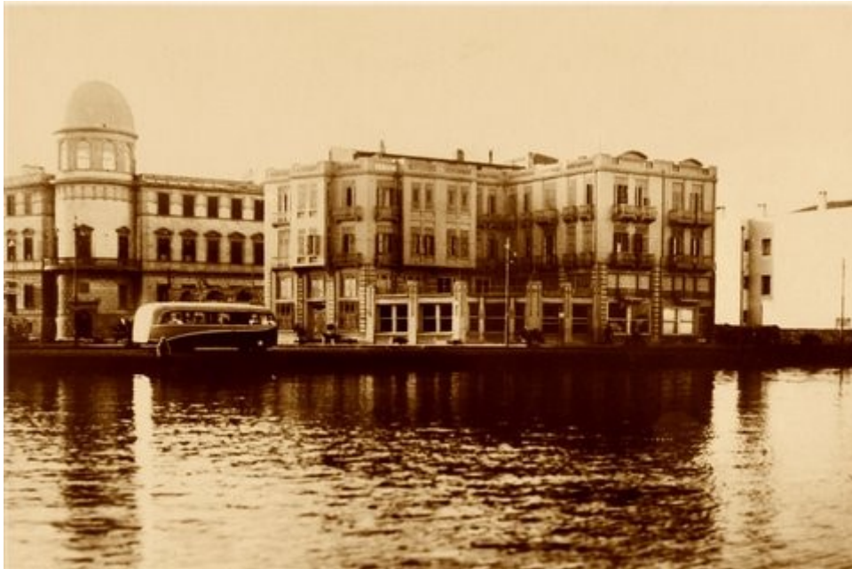
Fig. 71: Stefano Molli, Scuola femminile italiana “centrale”, Vista dal mare, prima della demolizione negli anni 40’, Archivio e museo della città di Smirne.
