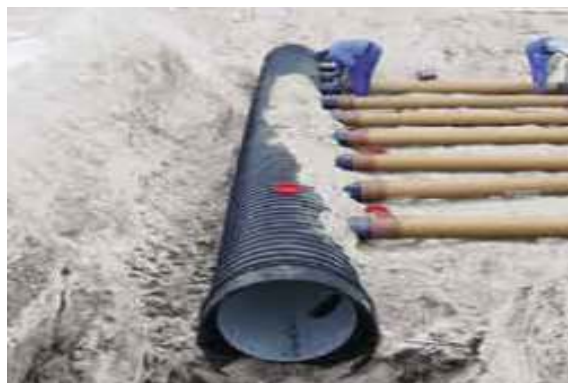
Figura 6.1. Posa in opera di uno scambiatore aria terreno.
