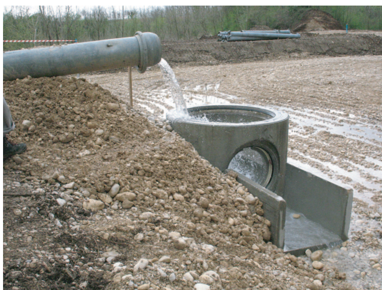
Figura 2.40: Tombino dissipatore per evitare lo scavo del fondo vasca.
