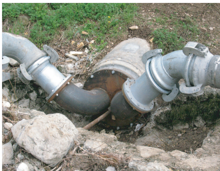
Figura 2.38: Raccordo dei due tubi DN 300 mm montato sul pezzo flangiato.
