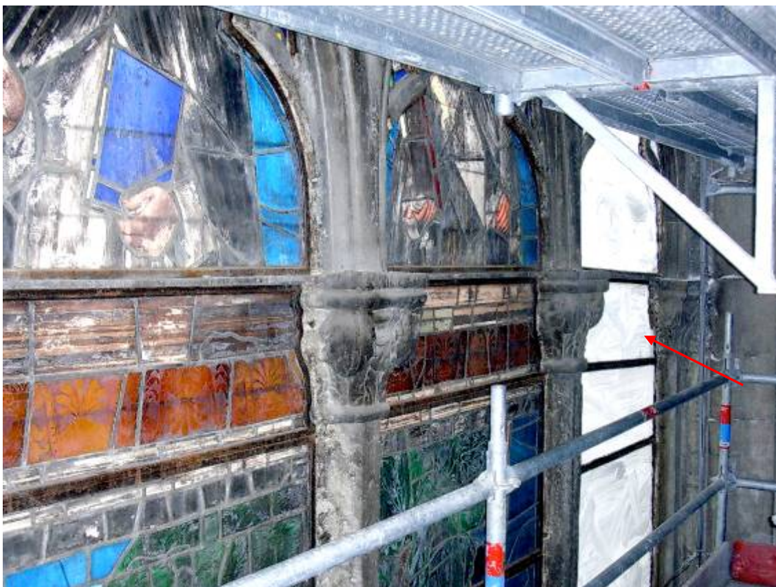
Fig. 8.3: Antello 35 a. Foto della quadrifora bassa, si noti il vano finestra attualmente tamponato.
