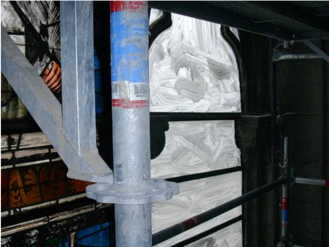
Fig. 8.4: Antello 35 a. Particolari del vano finestra tamponato con pannelli in pvc trasparente resi opachi con una vernice bianca lavabile
