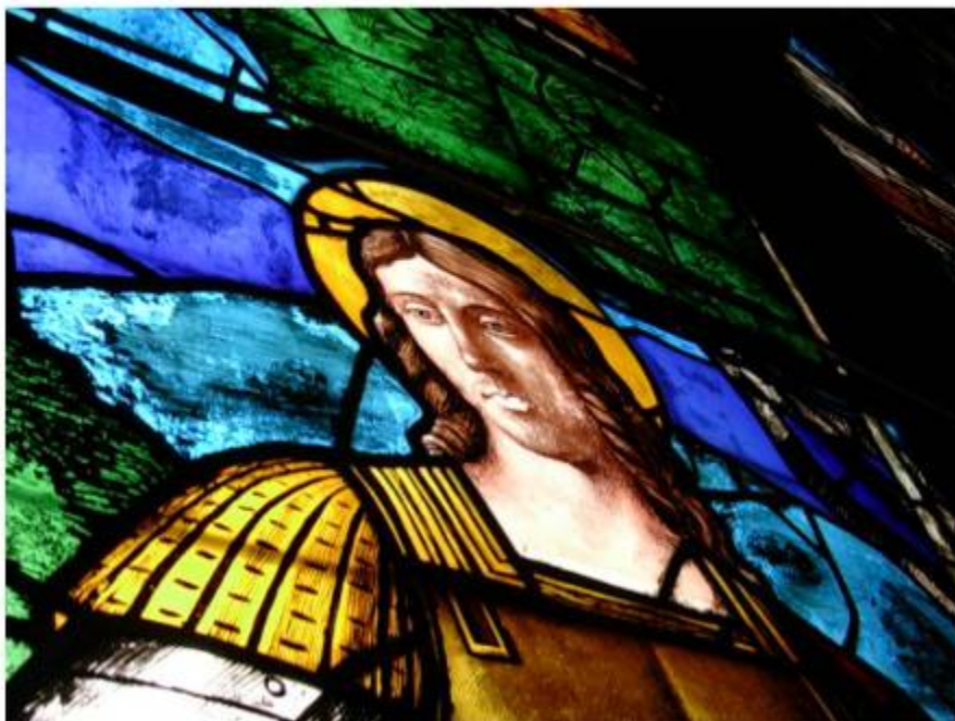
RILIEVO FOTOGRAFICO INTERNO - Spanciature degli antelli (particolare ant. 33c) -
