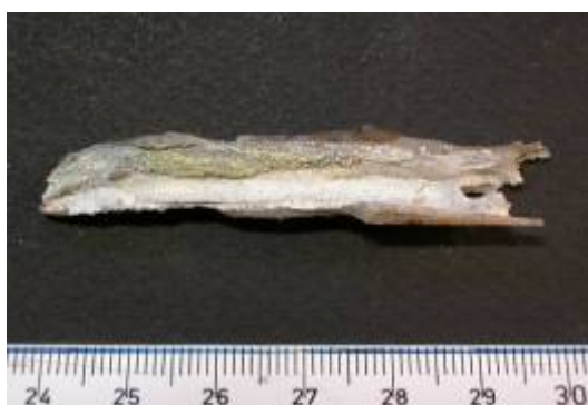
Fig. 8.36: Immagine del silicone perimetrale; è possibile vedere i depositi di corrosione sulla parte a contatto con i piombi.
