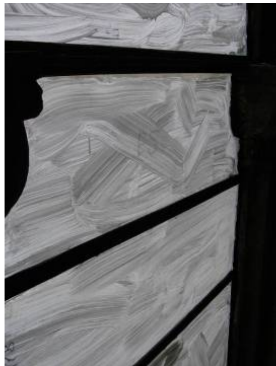
Fig. 8.4: Antello 35 a. Particolari del vano finestra tamponato con pannelli in pvc trasparente resi opachi con una vernice bianca lavabile
