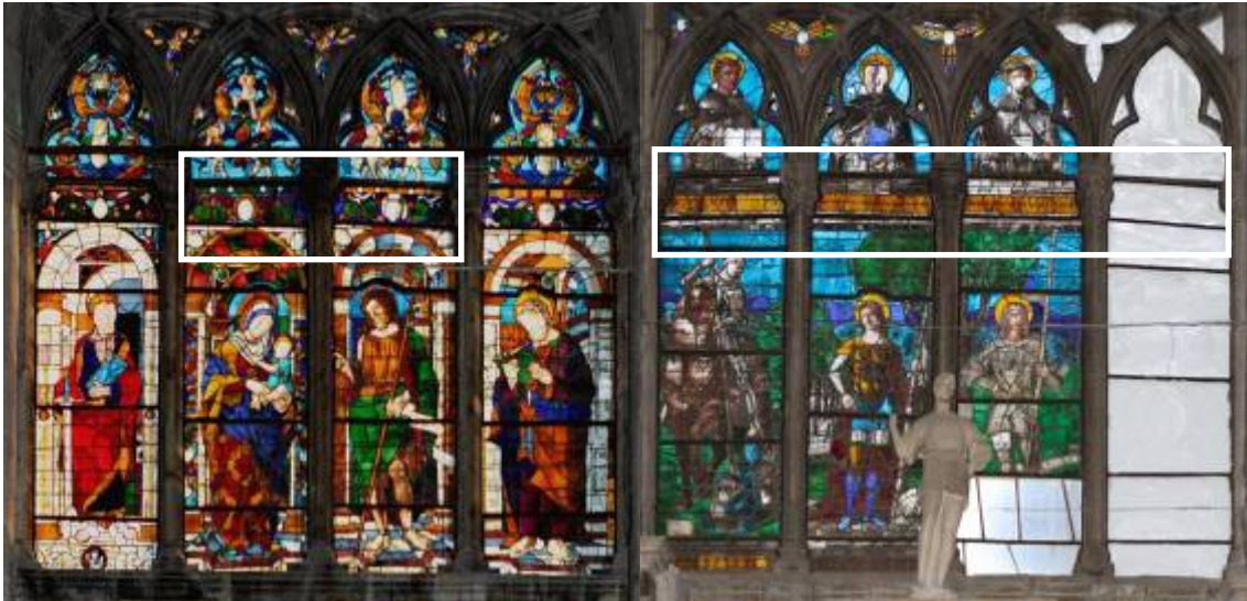
Fig. 6.2: Nei riquadri sono evidenziate le zone in cui sono ben visibili le deformazioni rispettivamente delle quadrifore alta e bassa
