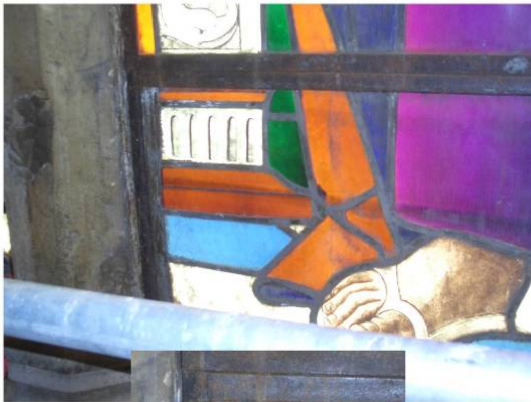
RILIEVO FOTOGRAFICO INTERNO - Accoppiamento di diversi righelli di piombo perimetrale -
