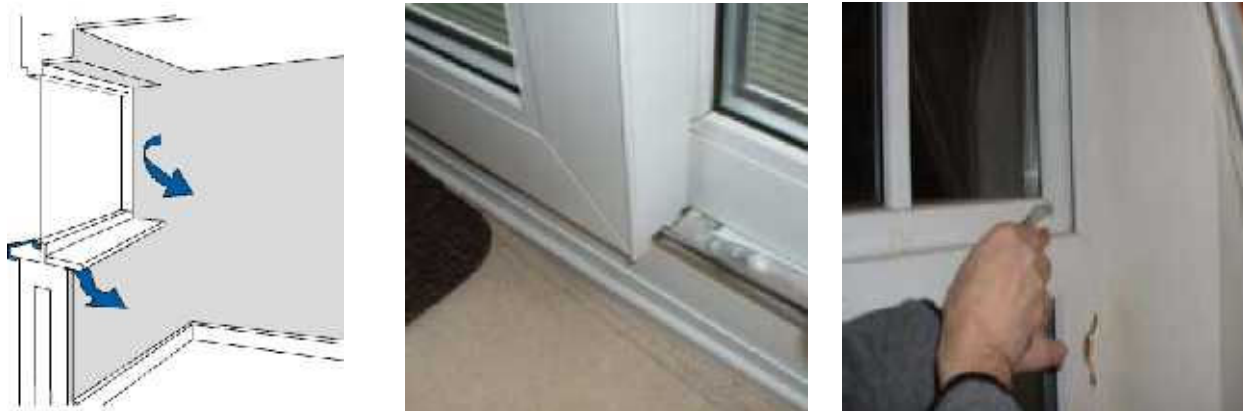
Fig. 3.2.1: infiltrazione per posa degli infissi approssimativa o per loro carenza progettuale, fonte: Energy Saving Trust, “Improving airtightness in dwellings”.
