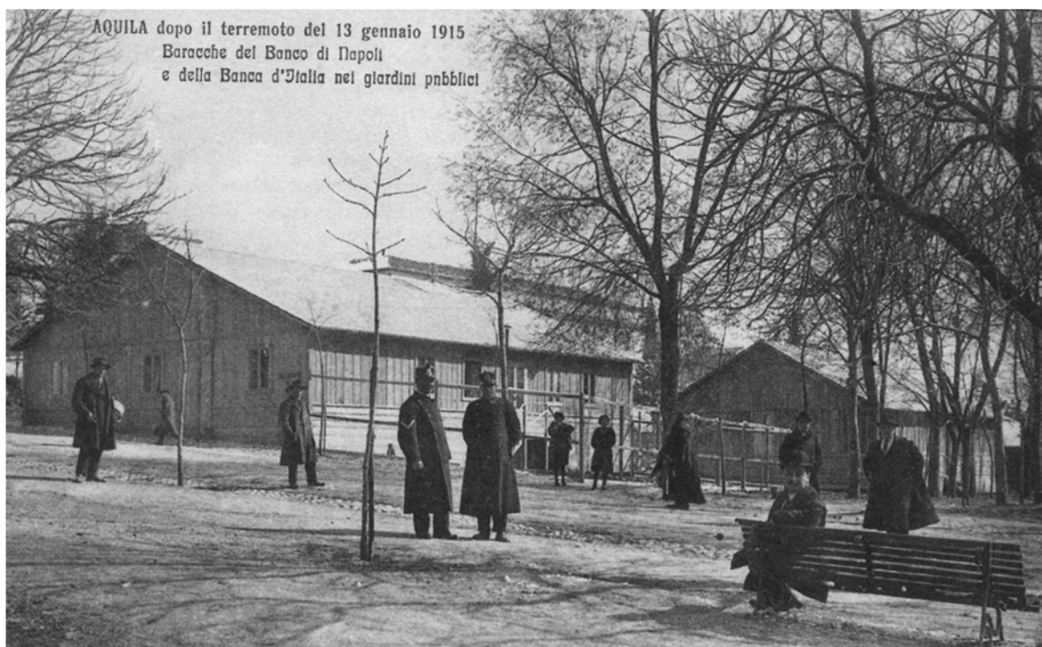
Figura 27 - Baracche del Banco di Napoli e della Banca d'Italia nei giardini pubblici dell'Aquila, dopo il terremoto del 13 gennaio 1915
