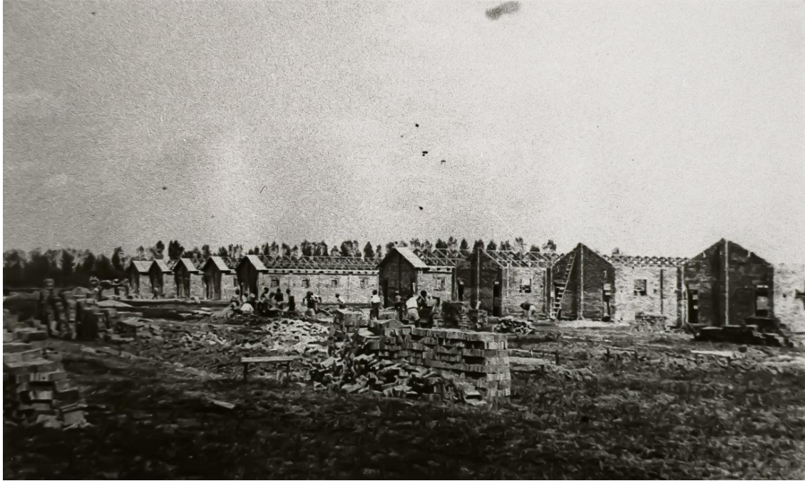
Fig. 50 – Il campo vecchio in costruzione, giugno 1942 (Archivio Storico di Nomadelfia).
