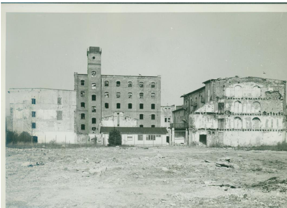
Fig. 18 – Lavori di trasformazione della Risiera di San Sabba in Museo della Resistenza, vista degli edifici che verranno preservati e musealizzati (Narodna in študijska knjižnica, Trieste).
