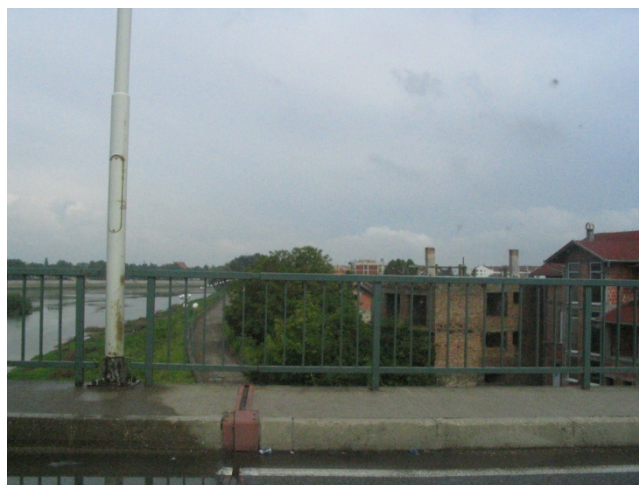
Fig. 8.14 – Bosanski Brod, il ponte sulla Sava che segna il confine tra Croazia e Bosnia Erzegovina (foto: Brusarosco A., 2006).
