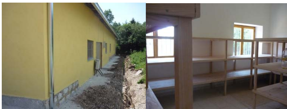
Fig. 10.10 – Il centro per la stagionatura, la promozione e la vendita del formaggio nel sacco a Nevesinje: vista dall'esterno dell'edificio in costruzione e stanza per la stagionatura (foto: Brusarosco A., 2010).
