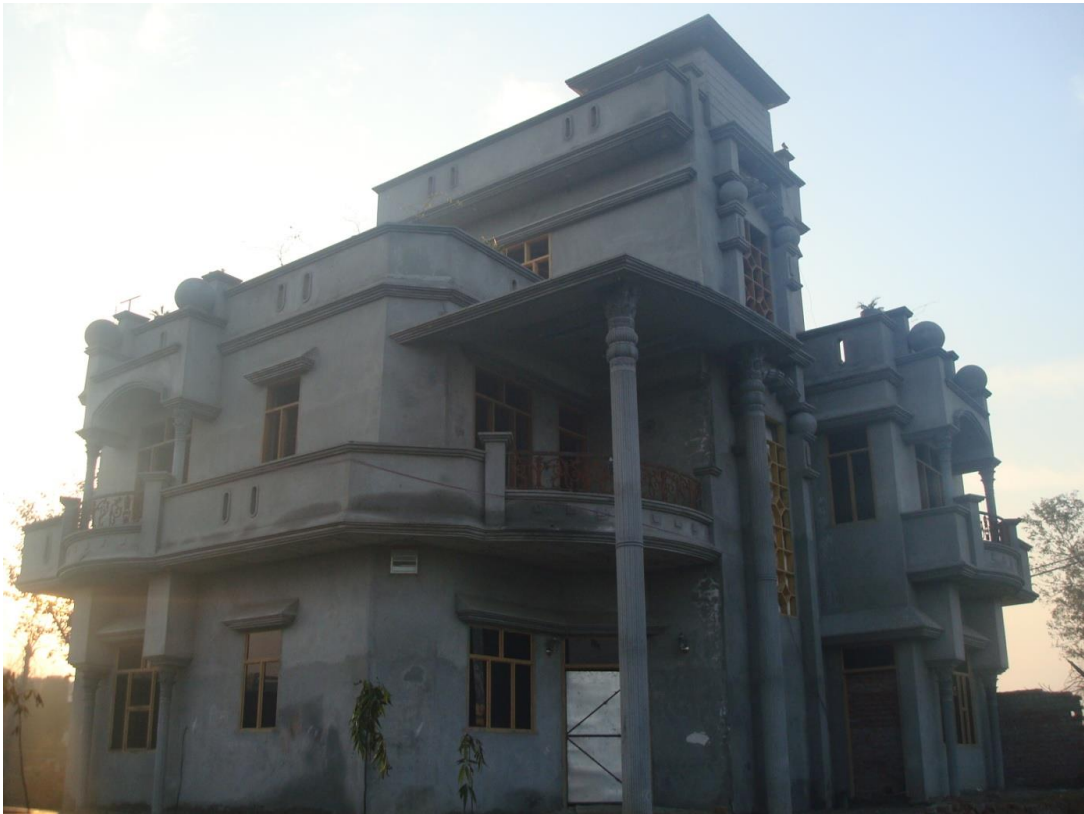
Foto 4 Casa in panjabi style, Pla Chak (Jalandhar), 01/02/2013
