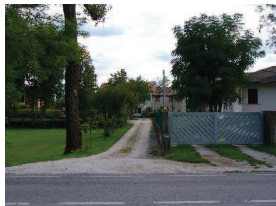
Fig. 36 Evidente in contrasto causato dalla modellazione del suolo. La quota di campagna è stata rialzata nell'abitazione di destra.
