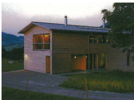
Fig. 43 Il complesso di casa Wood.
