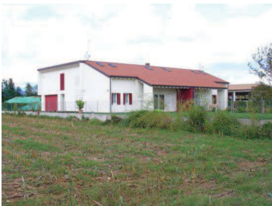
Fig. 35 Un caso in cui il piano di campagna dell'abitazione è stato rialzato rispetto alla campagna circostante.
