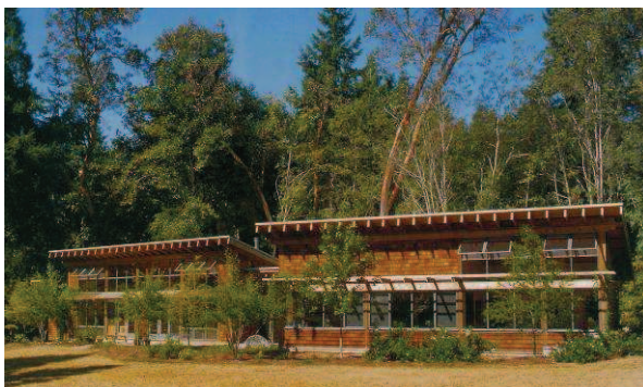
Fig. 41 Il complesso di casa Wood.
