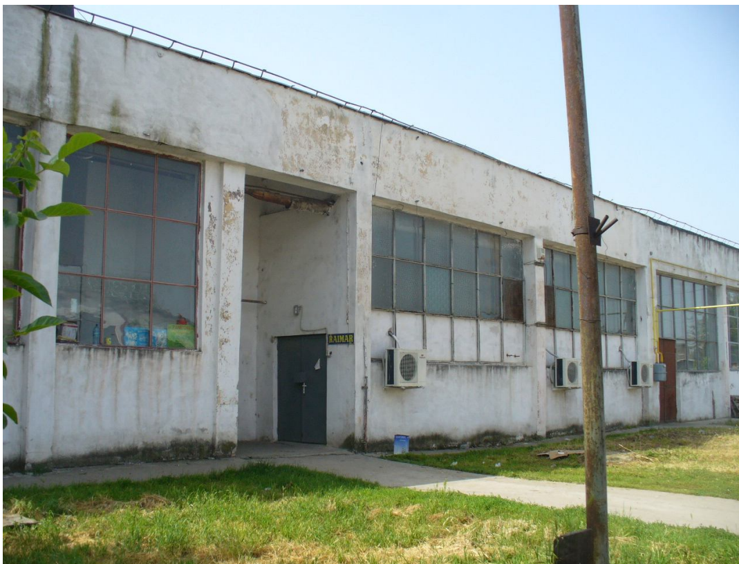
Photo 24. Un hangar loué à une entreprise de chaussures (Photo: Scroccaro, 2010)
