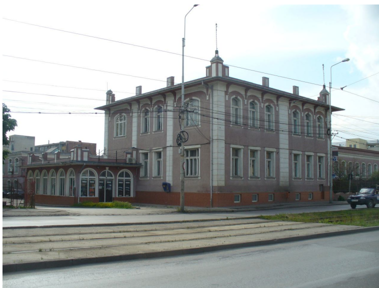
Photo 4. L'ex-usine étatique Banatim à Timișoara (Photo: Scroccaro, 2010).
