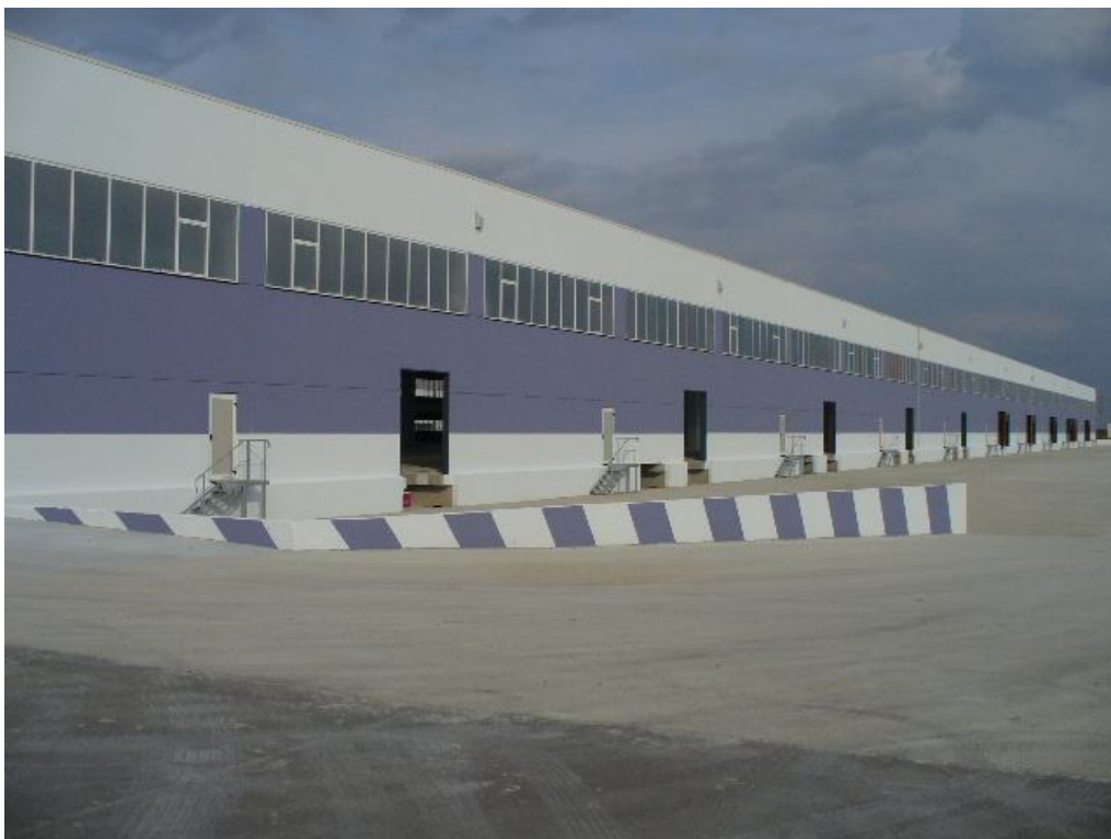
Photo 28. Exemple de magasin de stockage des matériaux (Photo: Scroccaro, 2008)
