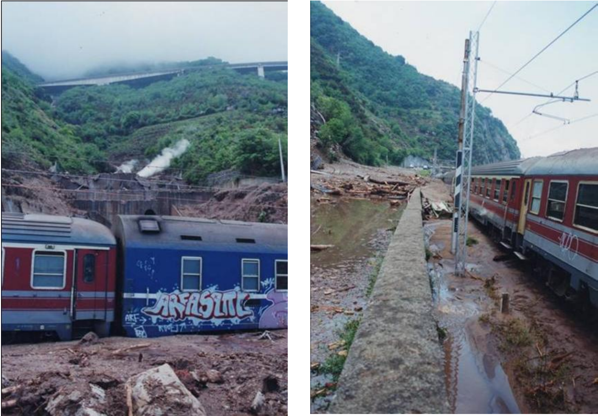
Figura 8.22: zona di valle della frana dove c'è stato il deragliamento del treno
