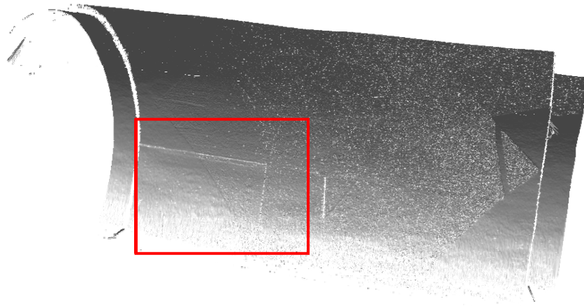
Figura 7 8 – mesh della volta, ruotata in modo da mettere in evidenza la parte sporgente, segnalata anche all’interno del riquadro rosso.
