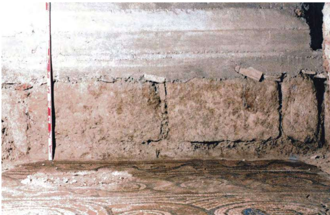
Fig.4. Alzados de sillería en la sala lateral norte de la cabecera (PENCO, 2000: 254).
