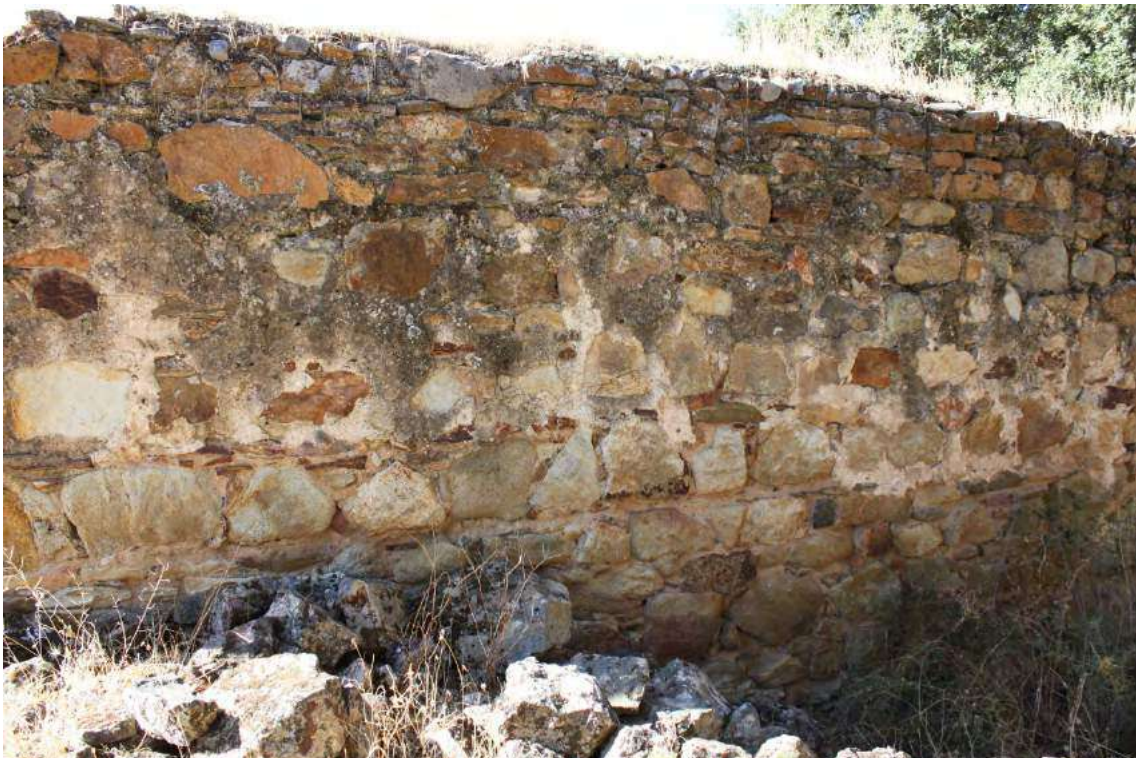
Fig.8. Paramentos en los que se aprecian varias fases constructivas.
