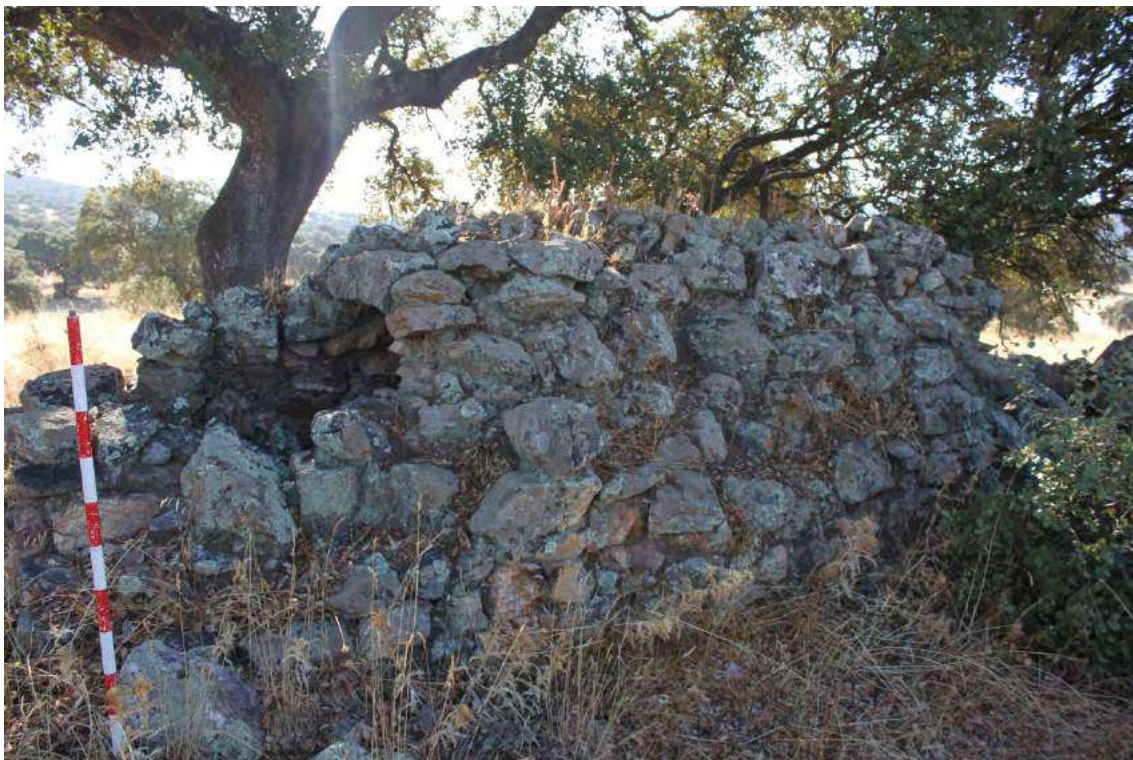
Fig.1. Sección de acueducto que transcurre junto a las ruinas de la ermita
