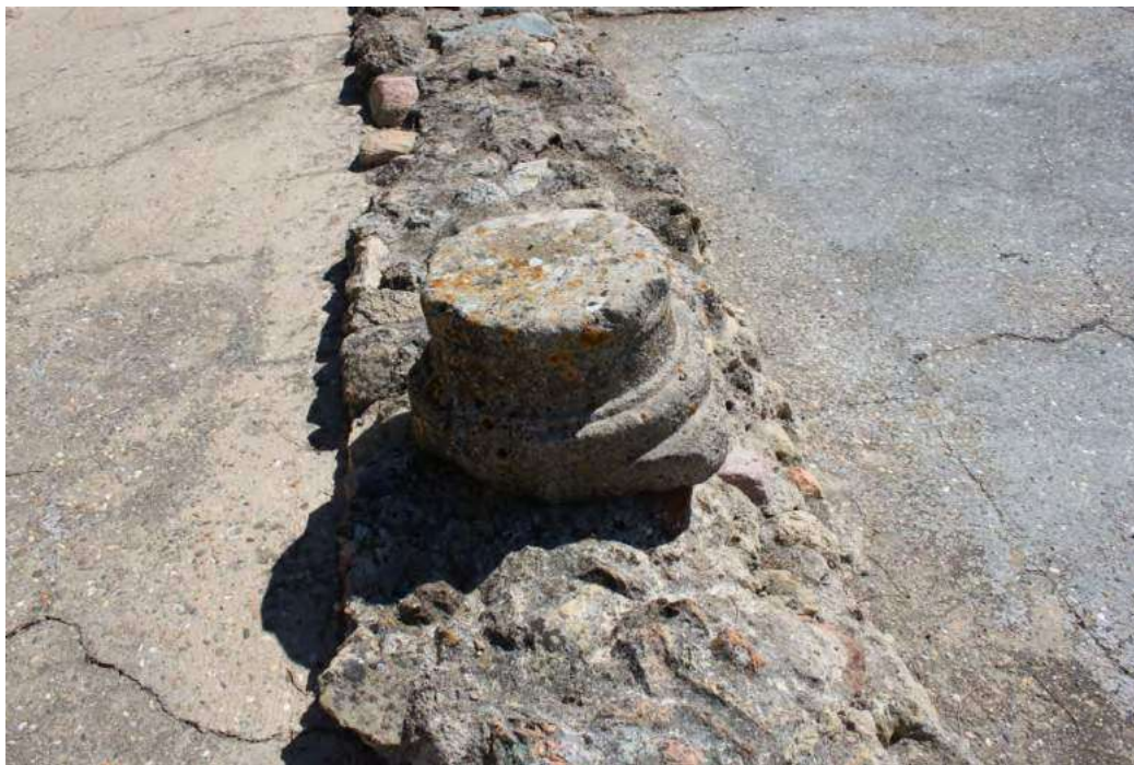
Fig.85. Cimentación corrida bajo la línea de columnas en la basílica de Gerena (Imagen del autor).
