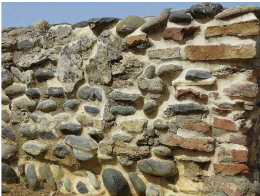
Fig. 90. Alzados de la basílica de la Vega del Mar. Obsérvese el empleo de ladrillo en las jambas y esquinas (Imagen del autor).
