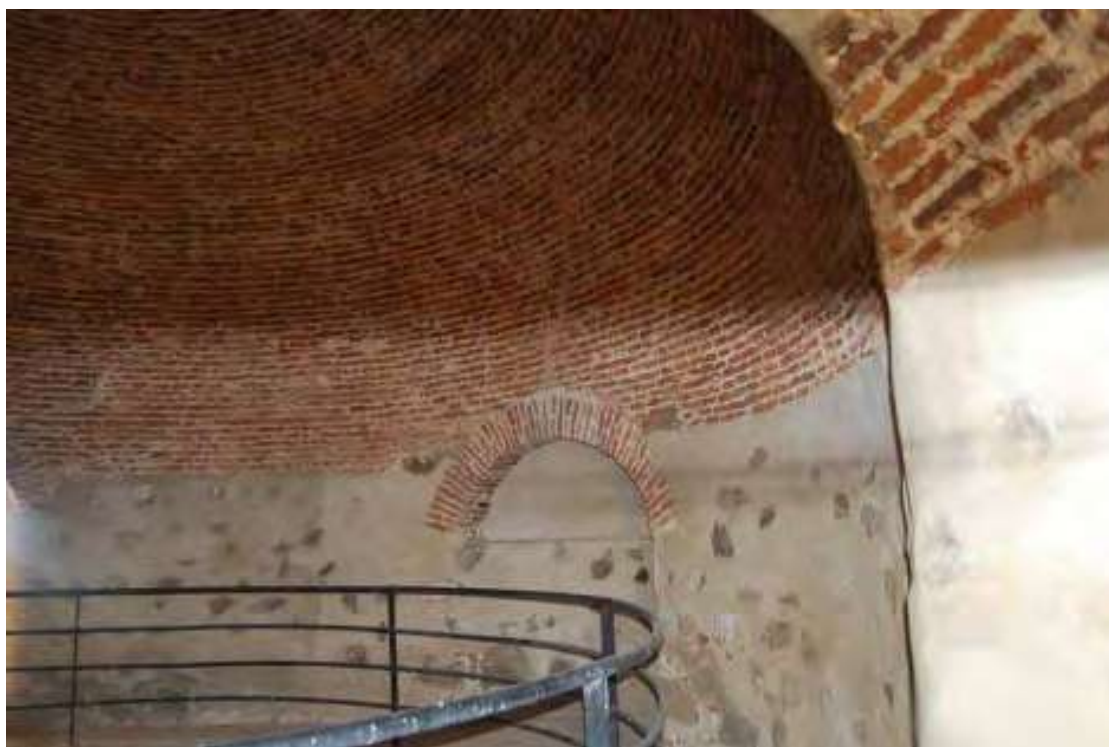
Fig. 4. Cúpula de ladrillo al Interior del Pozo de la Nieve.
