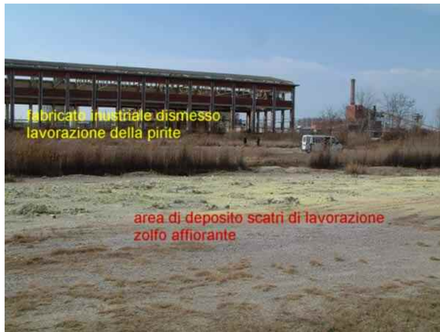
Figura 3 - Sopralluogo preliminare dell'area Caffaro di deposito materiale, in primo piano lo zolfo affiorante sulla pirite.
