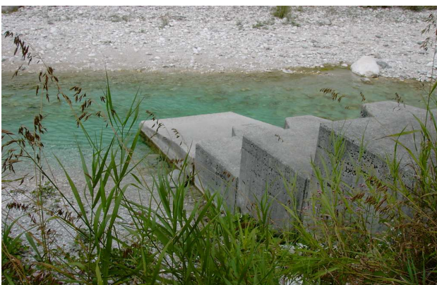
Figura 61: Opere di difesa spondale a monte del campo sportivo di Resia (sez 92-93).
