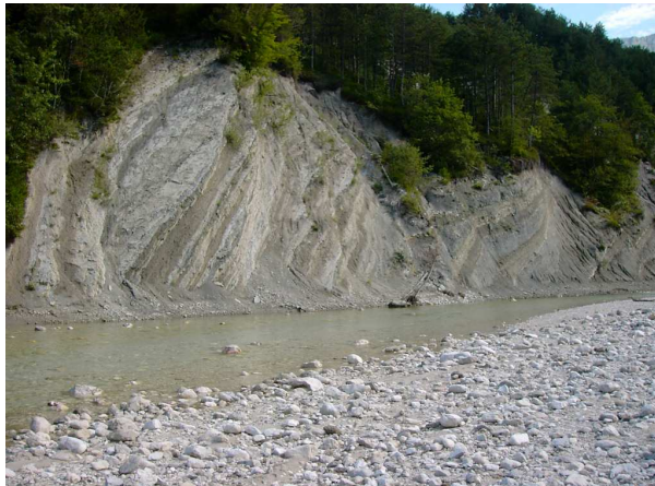
Figura 65: Barra laterale in corrispondenza della sez 118. Sul versante affioramento argillitico soggetto ad erosione.
