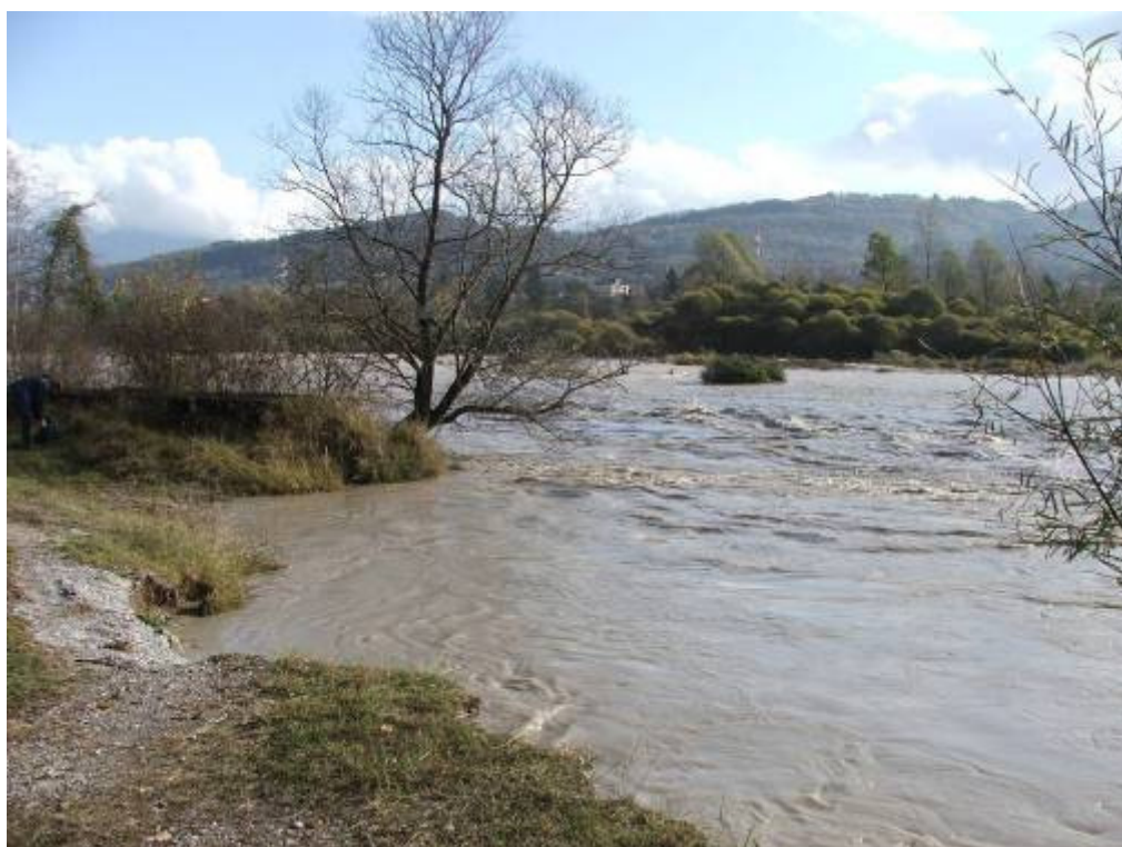
Figura 4.98 – Esempio di erosione localizzata al termine di una scogliera di protezione nella parte centrale del sottotratto 4
