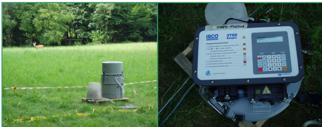
Figura 4.15: Campionatore ubicato in corrispondenza del pozzetto GP5.
