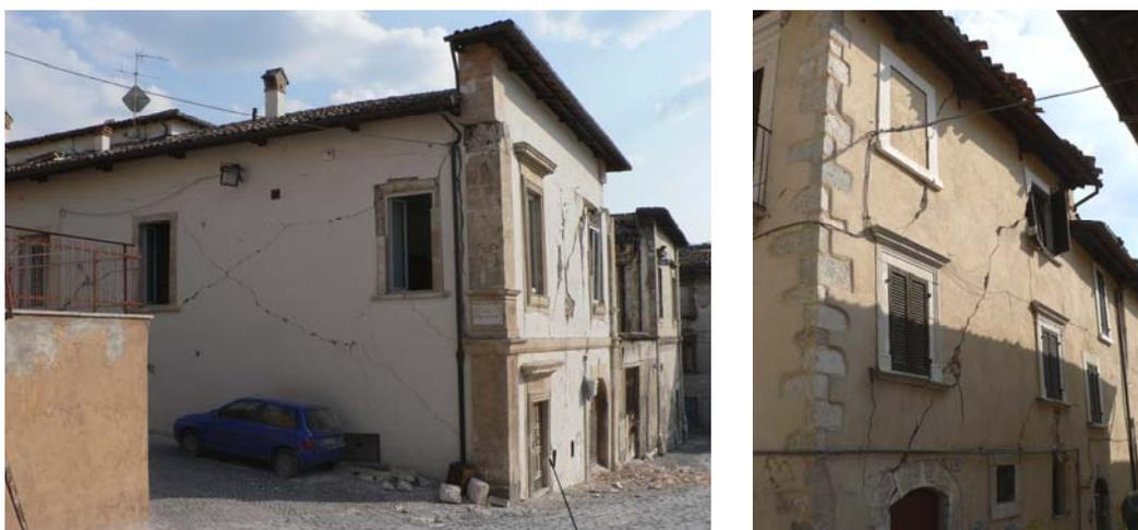
**Figura 1.6 – Alcuni meccanismi di secondo modo osservati nel Centro Storico de L’Aquila a seguito del sisma del 6 Aprile 2009**
