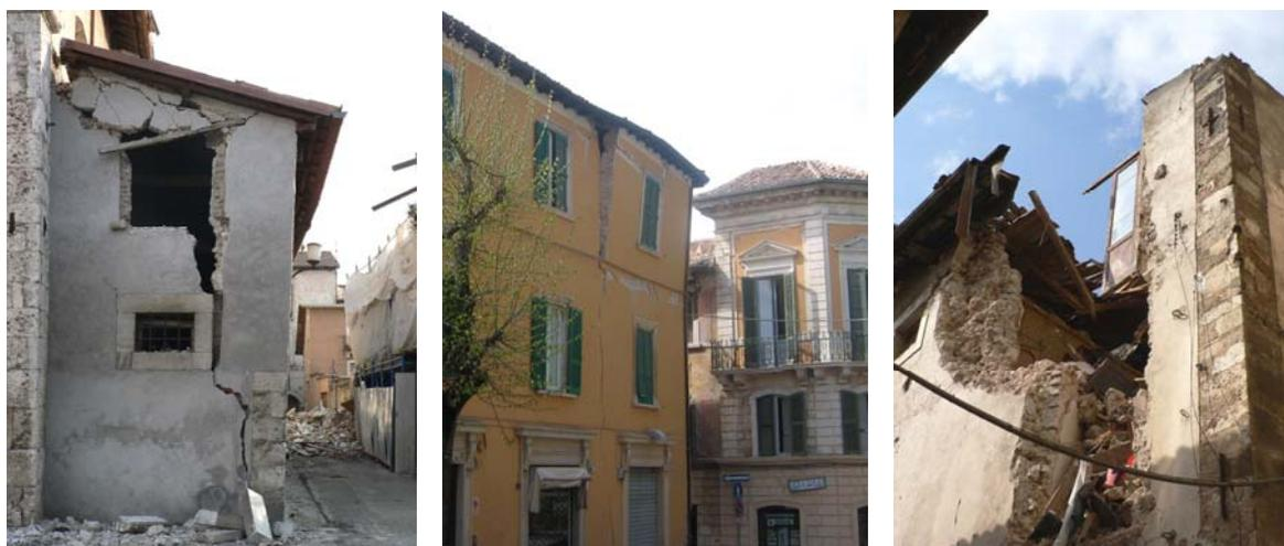
**Figura 1.5 – Alcuni meccanismi di primo modo osservati nel Centro Storico de L’Aquila a seguito del sisma del 6 Aprile 2009**
