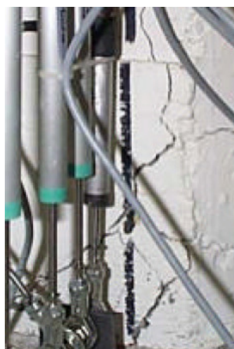
figura 2.99 – Fessure verticali e principio di spalling al termine del ciclo n°4 (ampiezza 40.00mm) [2.23]
