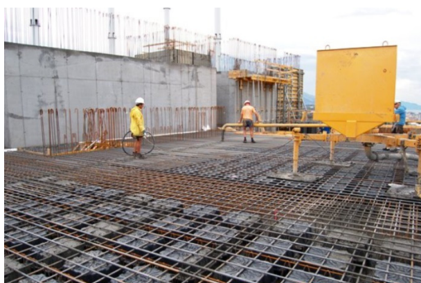
figura I.22 – Soletta piena alleggerita con moduli preassemblati [Rif. Internet]
