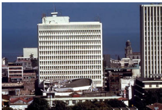
figura 1.4 – Banco Central de Nicaragua, danneggiato seriamente dopo un terremoto a causa dell'elevata eccentricità dei nuclei resistenti [Rif. Internet]
