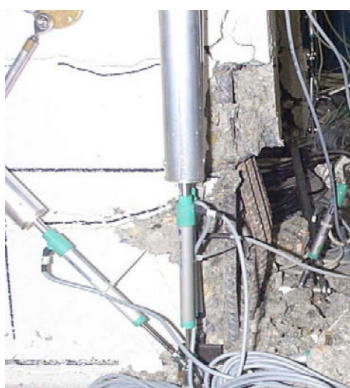
figura 2.87 – Instabilizzazione delle barre all'estremità della flangia al termine del ciclo n°7 (ampiezza 80.00mm) [2.22]
