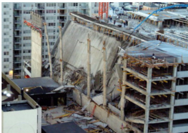
figura I.24 – Collapsi strutturali di strutture a soletta piena in seguito ad eventi sismici [Rif. Internet]
