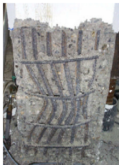
figura 2.107 – Espulsione del copriferro al termine del ciclo n°8 (ampiezza 120.00 mm) [2.23]
