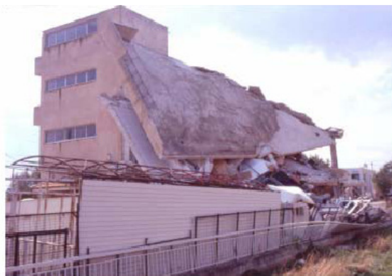
figura 1.3 – Edificio collassato a causa di effetti torsionali [1.4]
