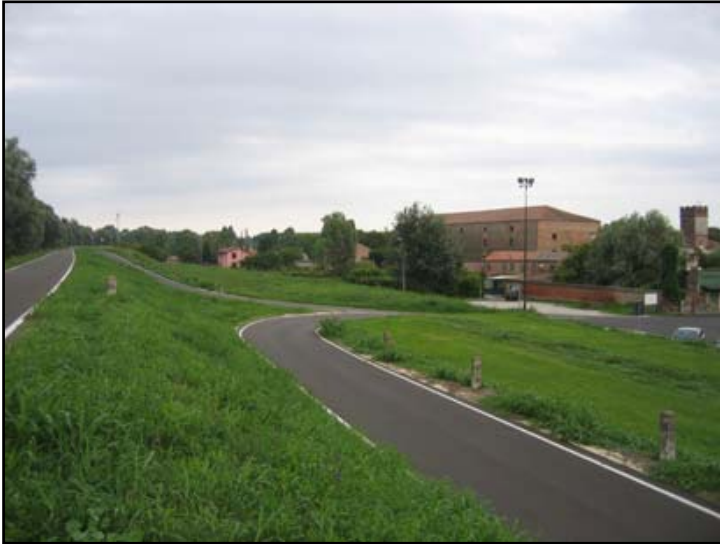
Fig. 42 – Allargamento dell'argine artificiale (banca e sottobanca) del fiume attuale in corrispondenza dell'inserzione del vecchio corso.
