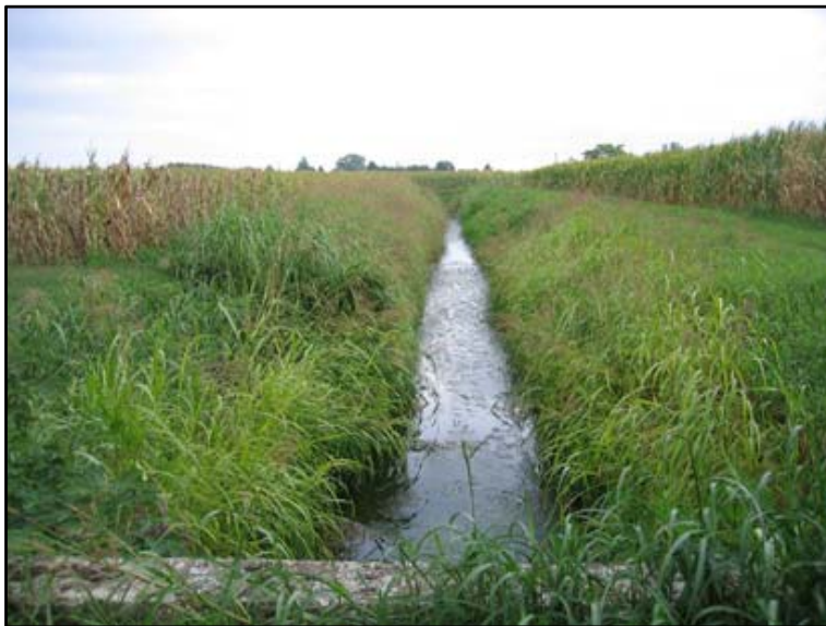
Fig. 37 – Fossato tra la prima curva a gomito ed il ponticello: ciò che rimane del canale di drenaggio che portava le acque dal centro del paleomendro allo scolo Ceresolo.
