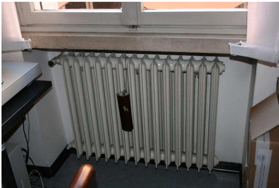
Figura 88- Radiatore un ufficio inserito in una nicchia
