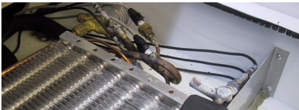
Figura 2.3.9 – Valvola meccanica TXV.
