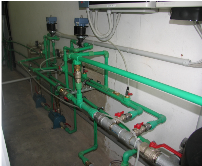
Figura 2.8.3 – Circuito idraulico della camera di test.
