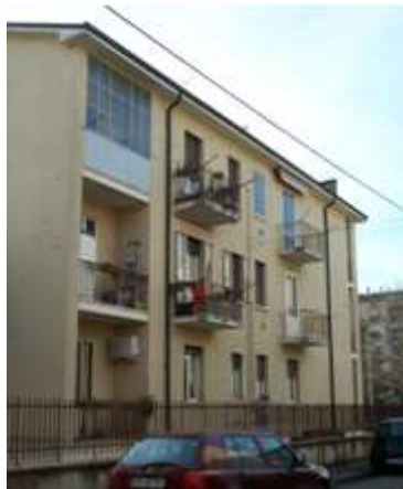
Immagini dell'esterno della palazzina E1 prima della ristrutturazione
