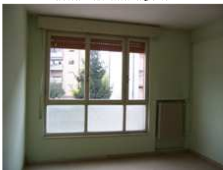
Immagini dell'interno della palazzina D prima della ristrutturazione
