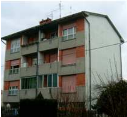
Immagini dell'esterno della palazzina D prima della ristrutturazione
