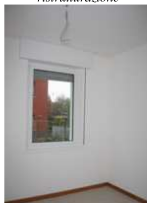
Immagini dell'interno della palazzina E1 dopo la ristrutturazione
