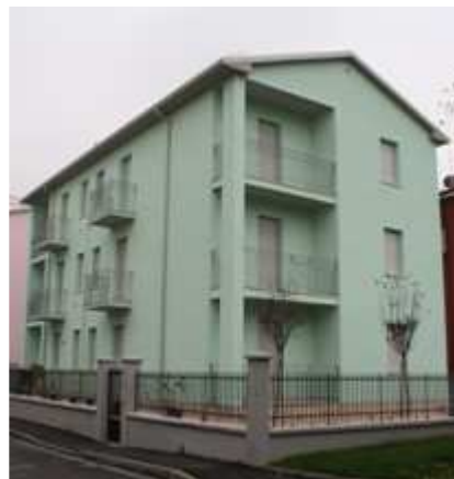
Immagini dell'esterno della palazzina E1 dopo la ristrutturazione
