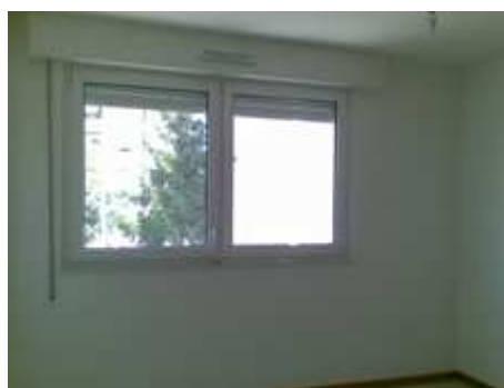
Immagini dell'interno della palazzina D dopo la ristrutturazione
