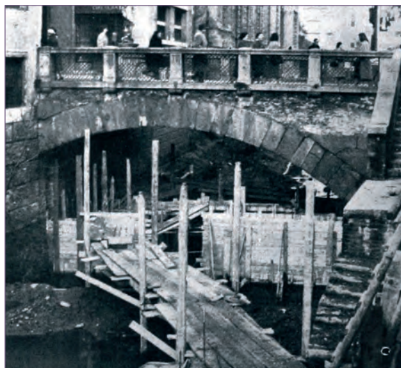
fig. 3. Il prospetto meridionale dell'arcata mediana del ponte Altinate durante i lavori per l'interramento del Naviglio Interno, poco prima della sua definitiva obliterazione sotto la superficie stradale (da Padova. Una storia per immagini 2007).
