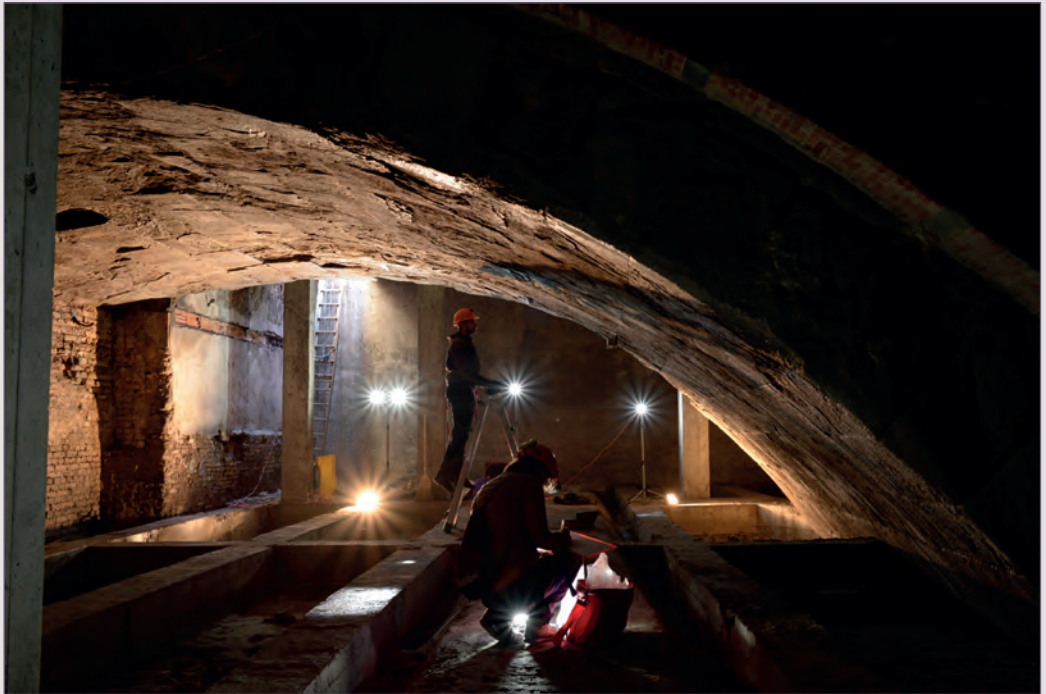
Analisi e rilievo dell'arcata mediana del ponte Altinate in occasione di uno dei sopralluoghi effettuati nel 2018.
