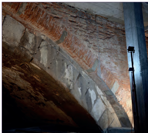
fig. 8. Copertura in mattoni e blocchi di trachite visibile sul lato sud dell'arcata mediana, posta a rinforzo e copertura della struttura originaria.
