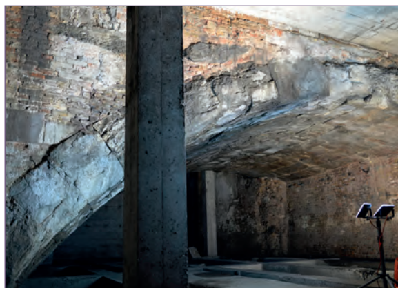
fig. 9. Fronte settentrionale dell'arcata mediana visibile all'interno del vano sotterraneo sottostante Riviera dei Ponti Romani.
