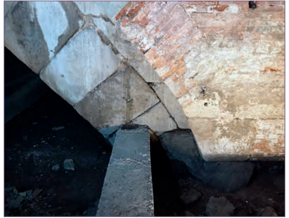
fig. 7. L'estremità orientale dell'arcata mediana di ponte Altinate, vista da sud. Si riconosce la presenza, alla base dell'arcata, di un rostro a diedro acuto.
